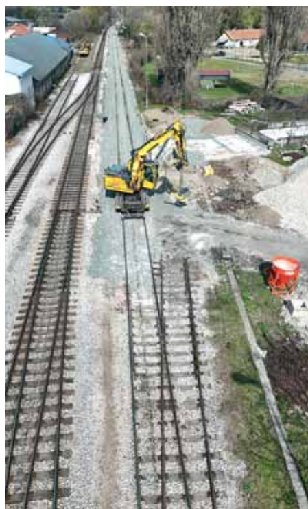
Radovi na skretnici u kolodvoru Varaždin
