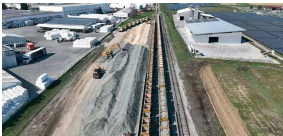
Prijevoz drobljenog kamena i tucanika za obnovu pruge
