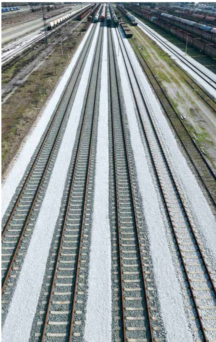
Obnovljeni kolosijeci u Ranžirnome kolodvoru
