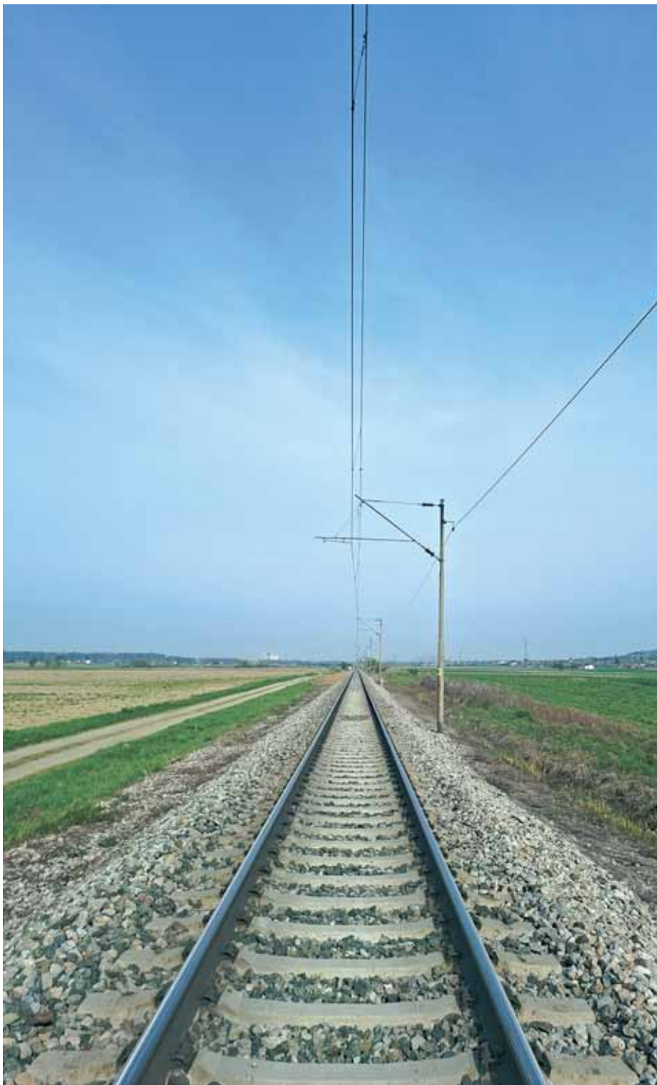
Obnovljena pruga na dionici Kutina – Deanovec
