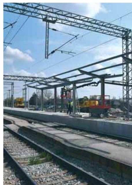
Radovi u kolodvoru Dugo Selo
