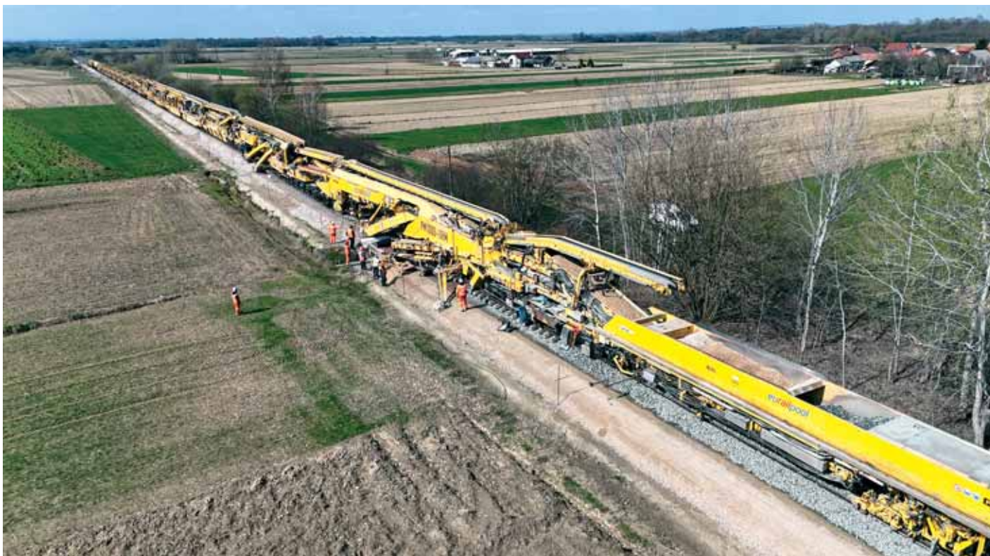
Pružno postrojenje PM 1000 za ugradnju zaštitnog sloja
