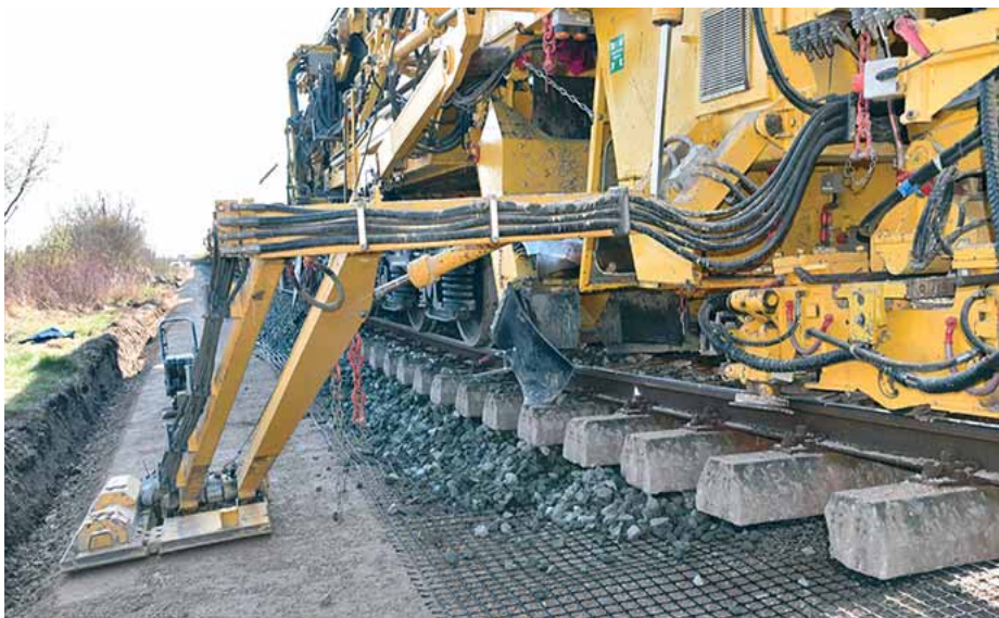
Ugradnja tucanika i zbijanje pokosa
