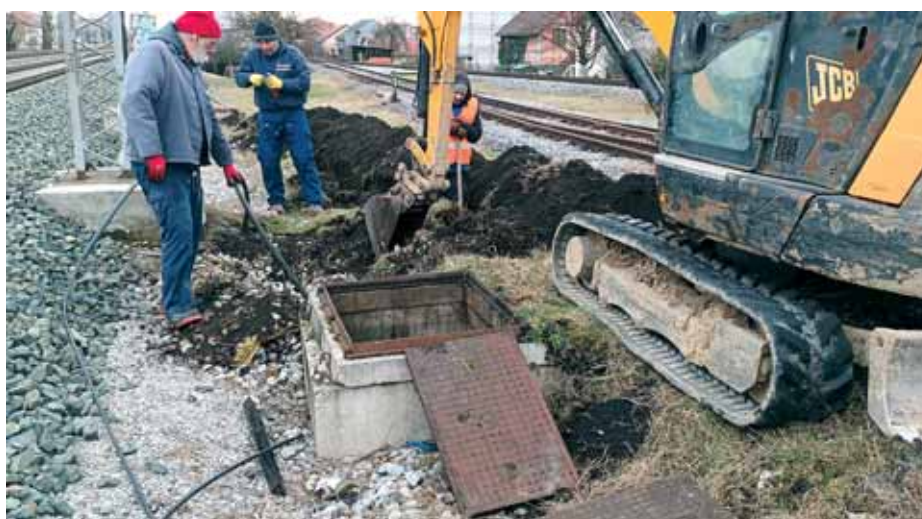
Provlačenje optičkog kabela u montažni zdenac
