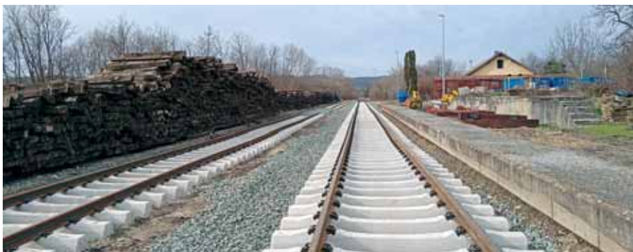
Obnovljeni kolosijeci u Lipiku
