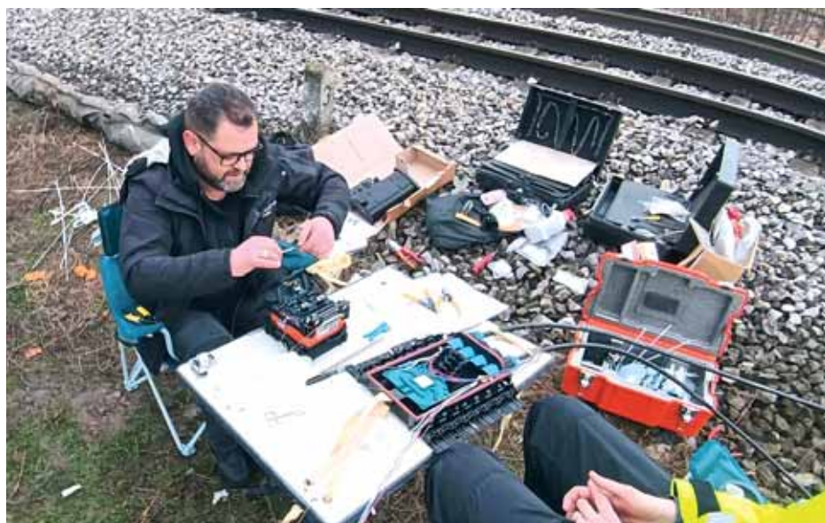
Izrada spoja dvaju optičkih kabela metodom fusion splice
