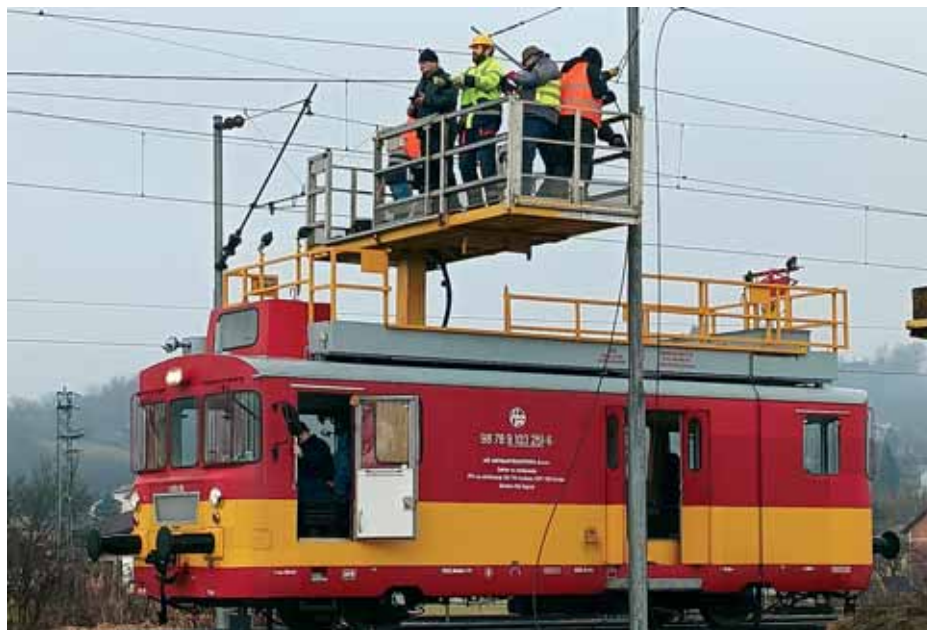
Zatezanje optičkog kabela na motornoj drezini
