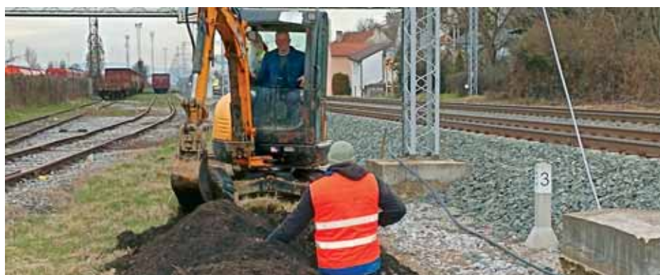
Iskop rova za polaganje PHD cijevi i kabela
