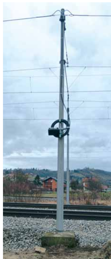
Optička spojnica na stupu kontaktne mreže
