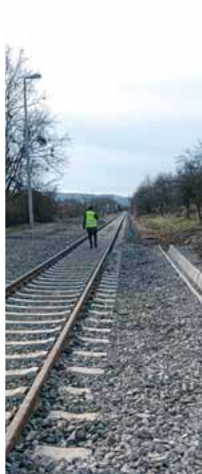
Obnovljeni kolosijek i sanirani propust u kolodvoru Pakrac grad
