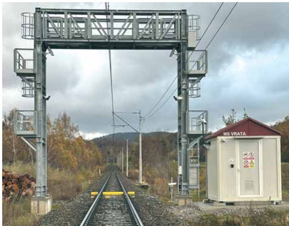
Sustav za automatsku kontrolu vozila u Vratima
