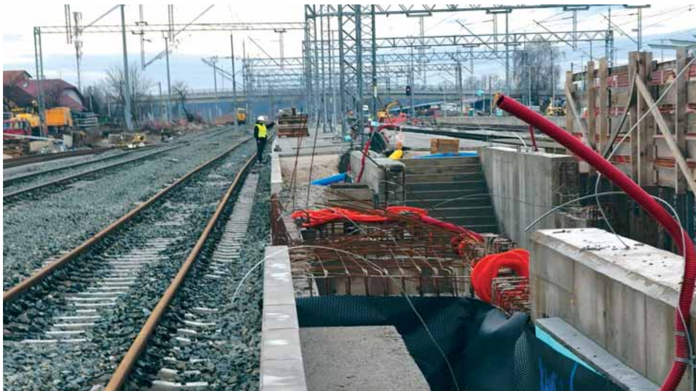
Radovi na pothodniku u kolodvoru Dugo Selo
