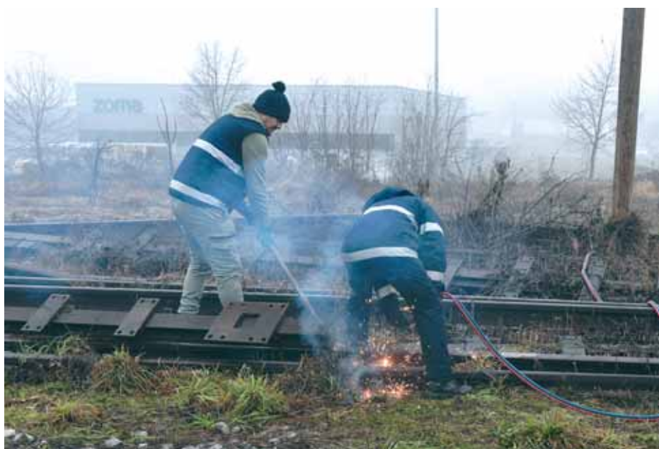
Rezanje tračnica
