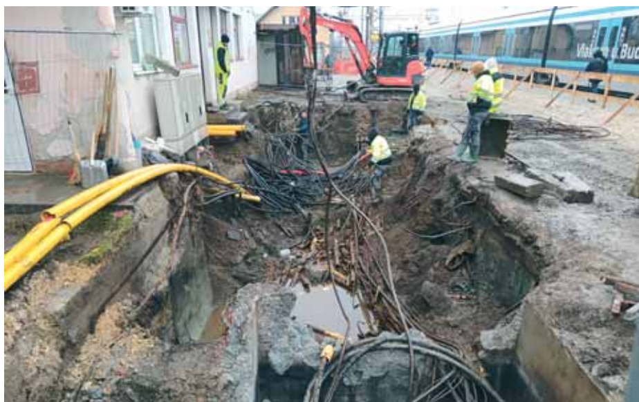
Izmještanje kabela zbog izgradnje temelja nadstrešnice u kolodvoru Dugo Selo
