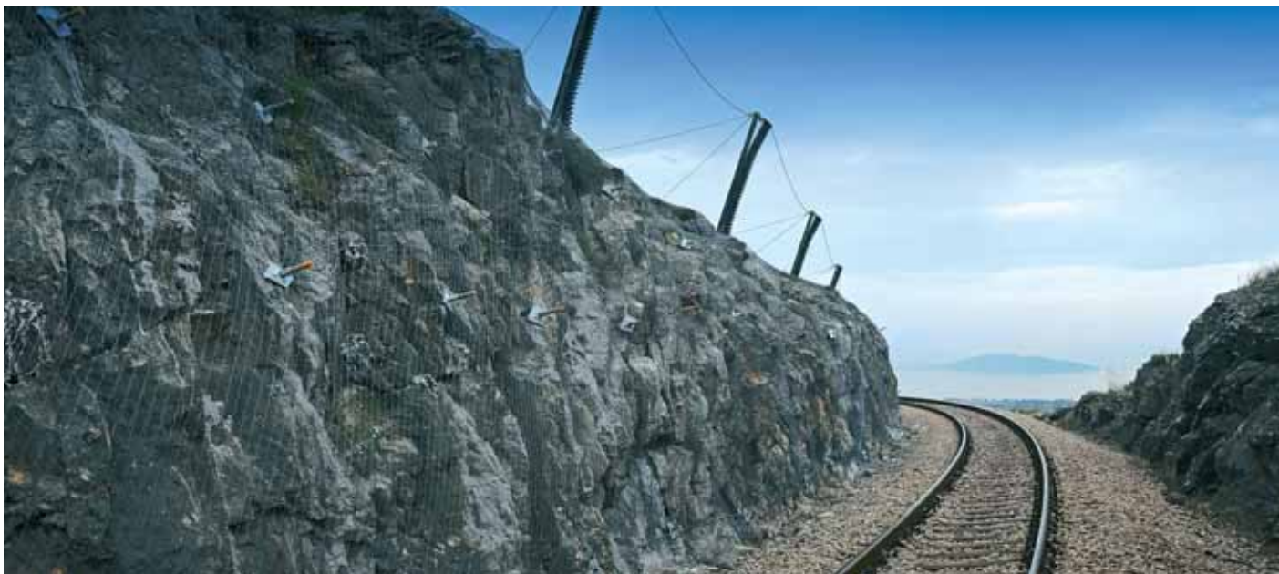
Završeni radovi na usjeku kod Labina Dalmatinskog
