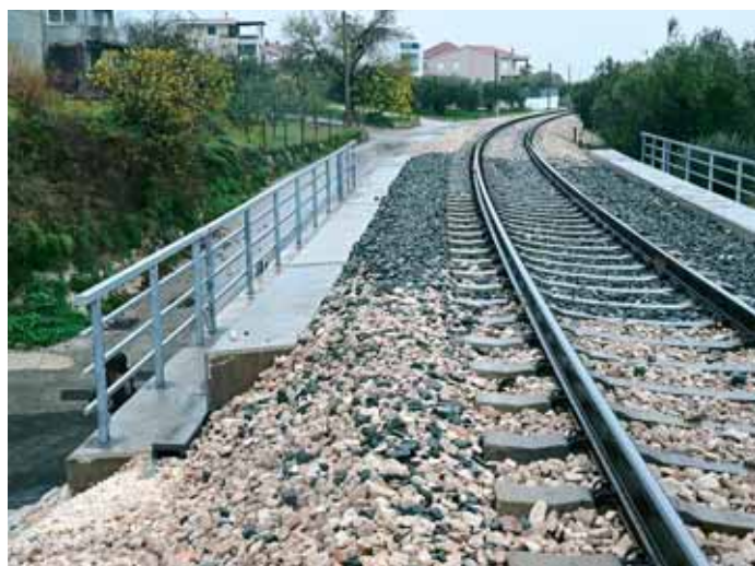
Završeni radovi na mostu »Kambelovac«
