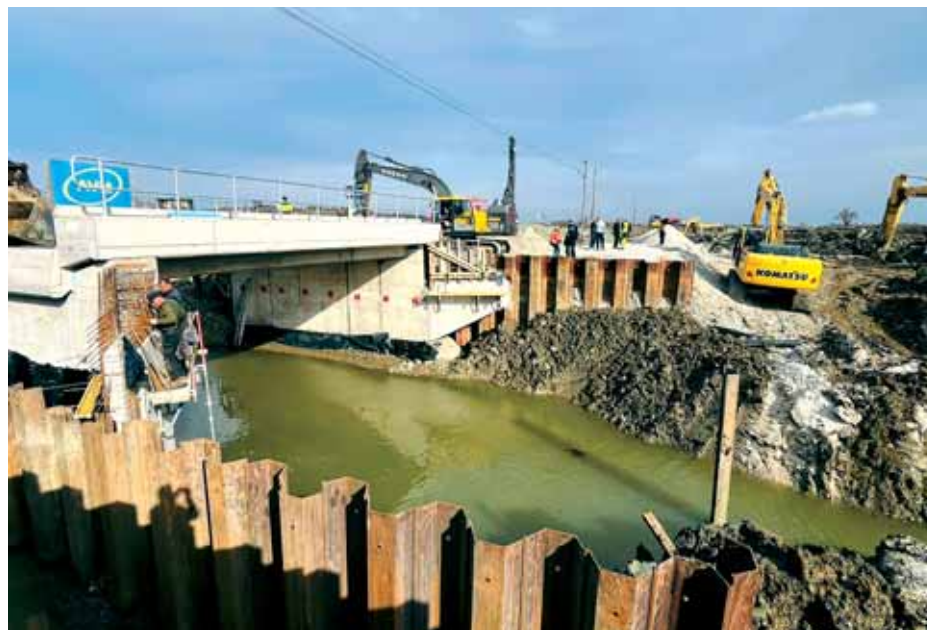
Radovi na mostu Zelina
