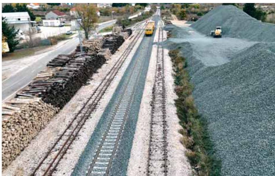
Radovi u kolodvoru Benkovac
