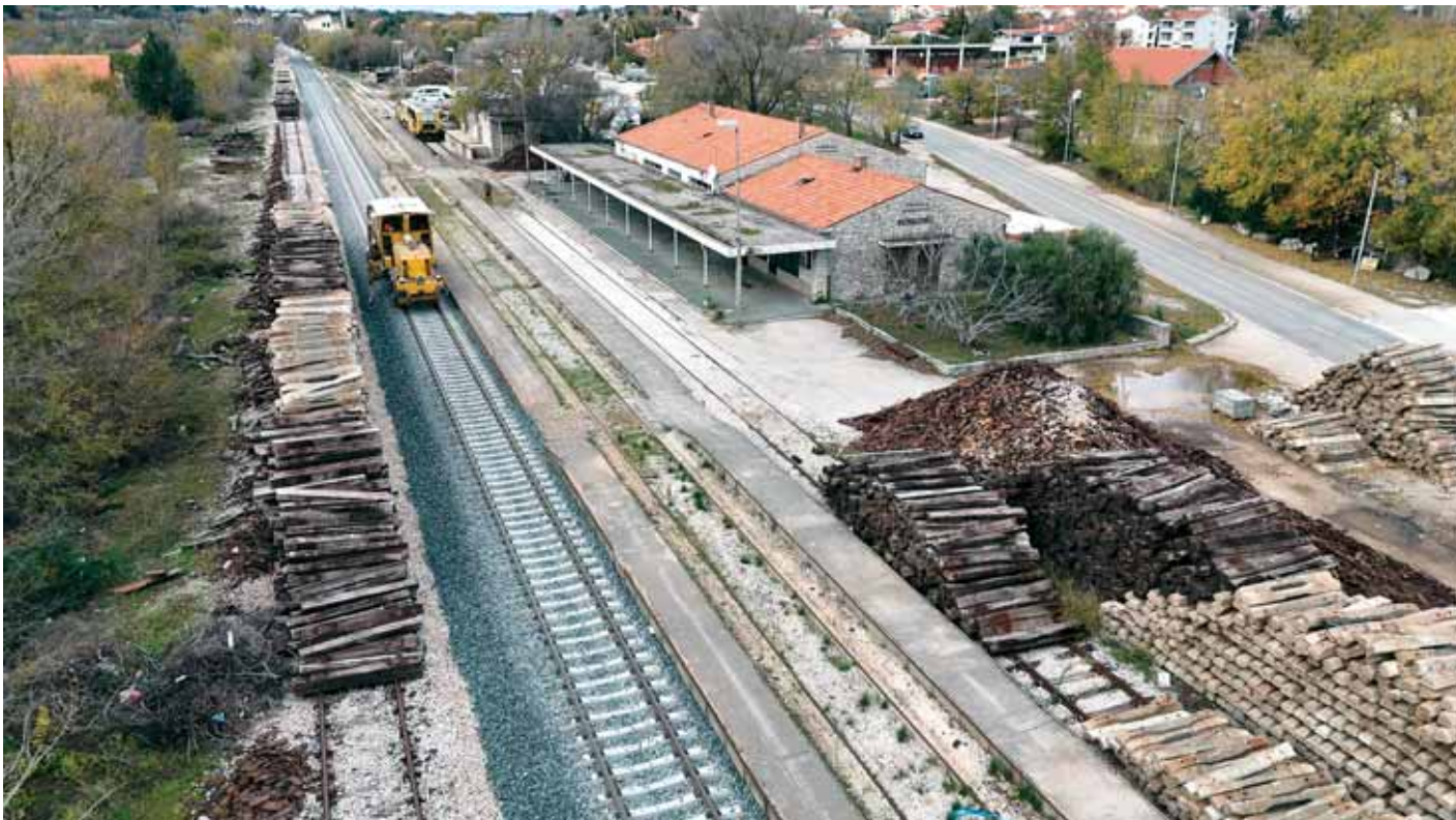
Radovi u kolodvoru Benkovac
