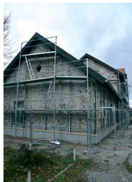
Vanjski radovi na kolodvorskoj zgradi u Gračacu
