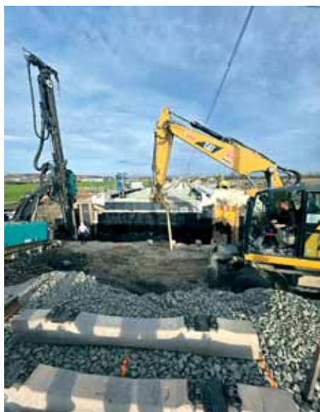
Radovi na mostu Zelina
