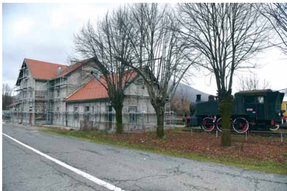
Vanjski radovi na kolodvorskoj zgradi u Gračacu
