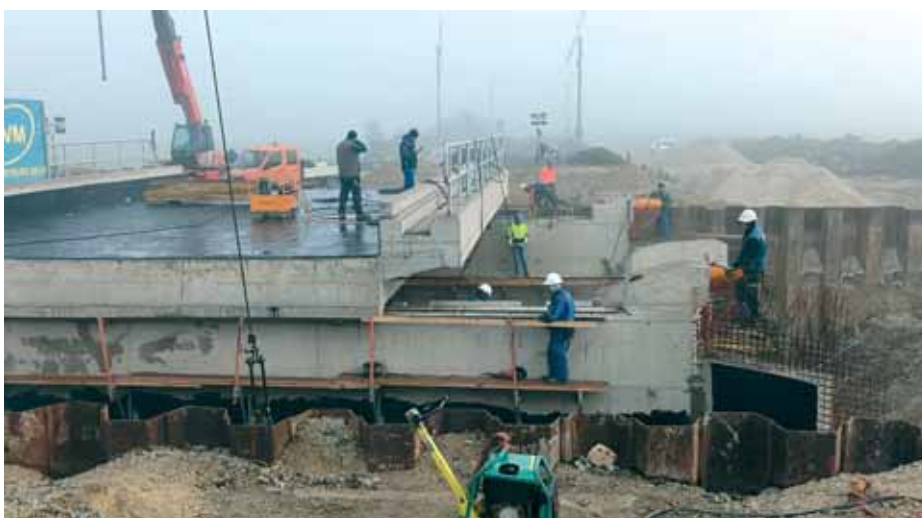
Radovi na mostu Zelina (montaža AB ploče povlačenjem)
