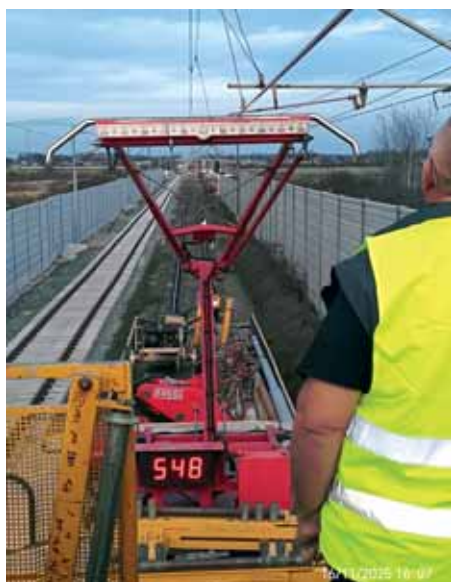
Radovi na kontaktnoj mreži
