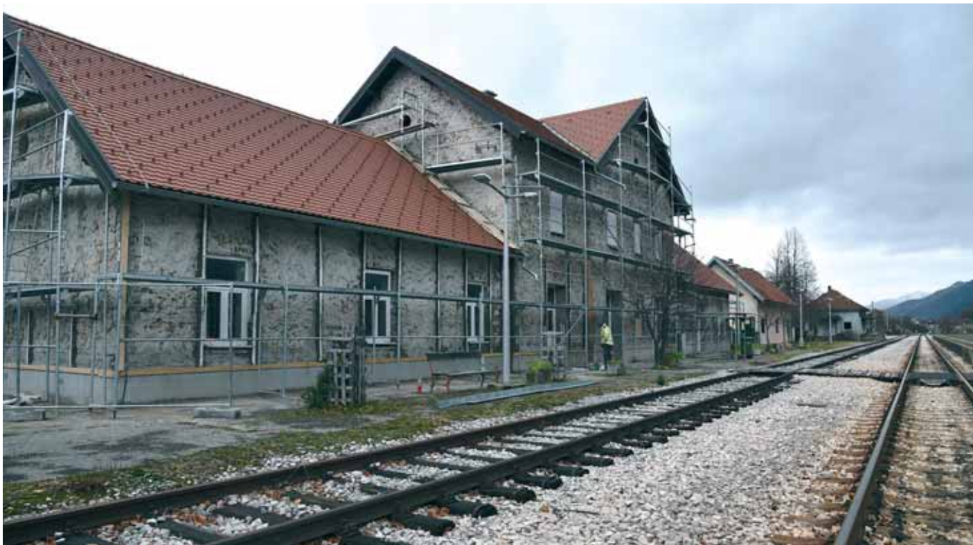
Obnova kolodvorske zgrade u Gračacu
