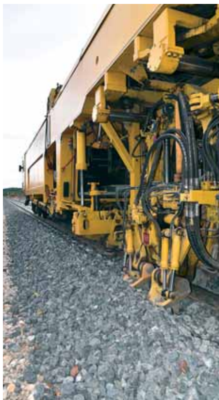
Strojno reguliranje kolosijeka
