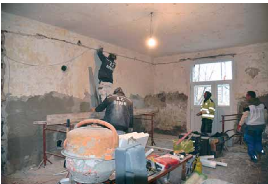
Unutarnji radovi na kolodvorskoj zgradi u Gračacu
