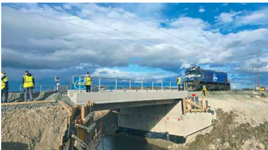
Radovi na mostu Zelina (probno opterećenje mosta)
