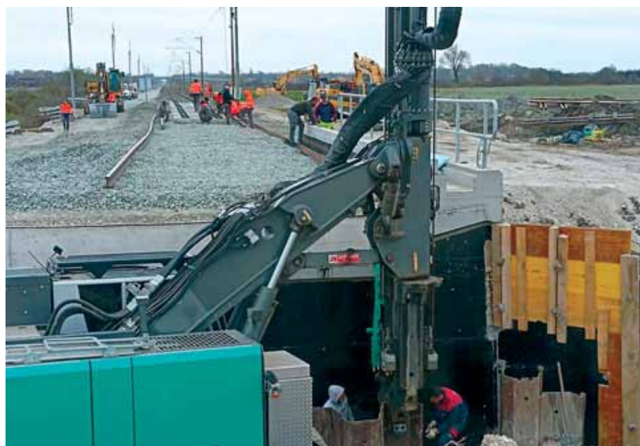
Radovi na mostu Zelina (izvlačenje talpi i polaganje kolosijeka)
