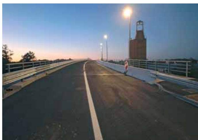
Dovršeni radovi na nadvožnjaku kod Ostrne
