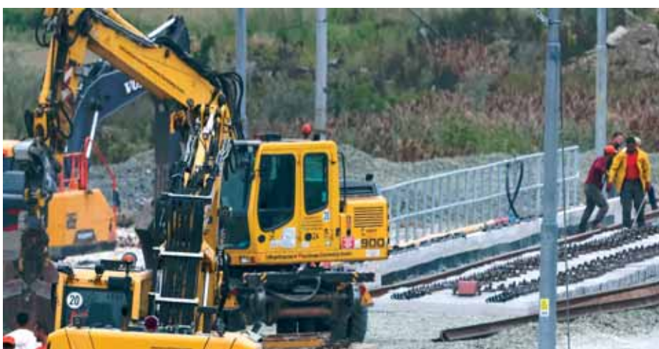
Radovi na gornjem ustroju na mostu Lonja
