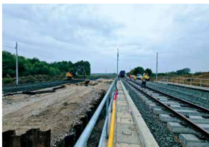
Radovi na uklanjanju privremene devijacije i ugradnji elemenata gornjeg ustroja
