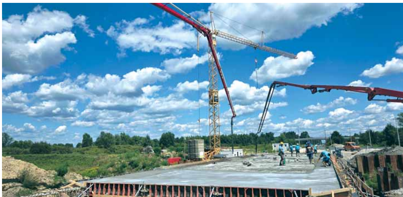
Radovi na betoniranju ploče na mostu Lonja
