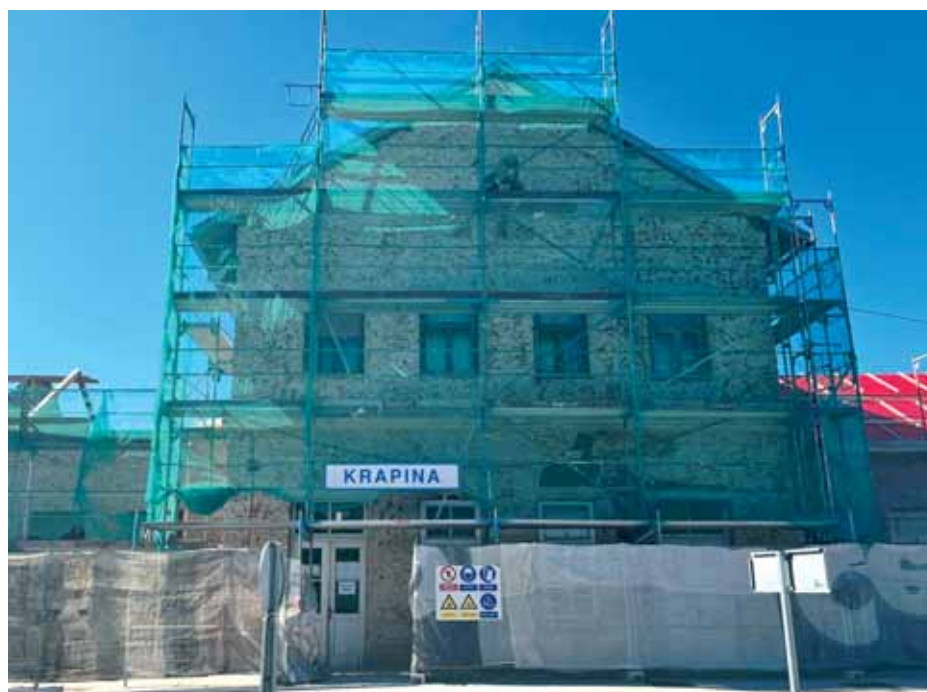
Radovi na obnovi kolodvorske zgrade u Krapini
