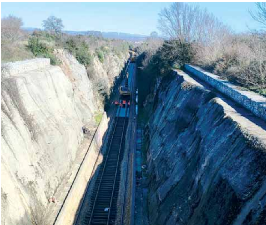
Radovi na željezničkoj pruzi ispred tunela Debeljak
