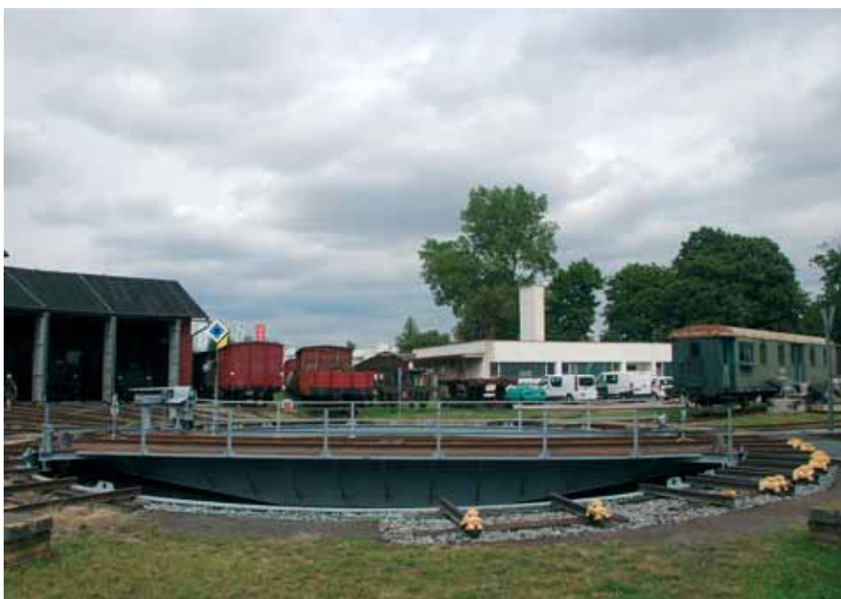
Željeznička okretnica i mali muzej u bivšoj zgradi ložionice Jaroměř
