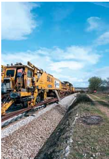
Rad specijaliziranog stroja SMD-80 na zamjeni pragova i tračnica
