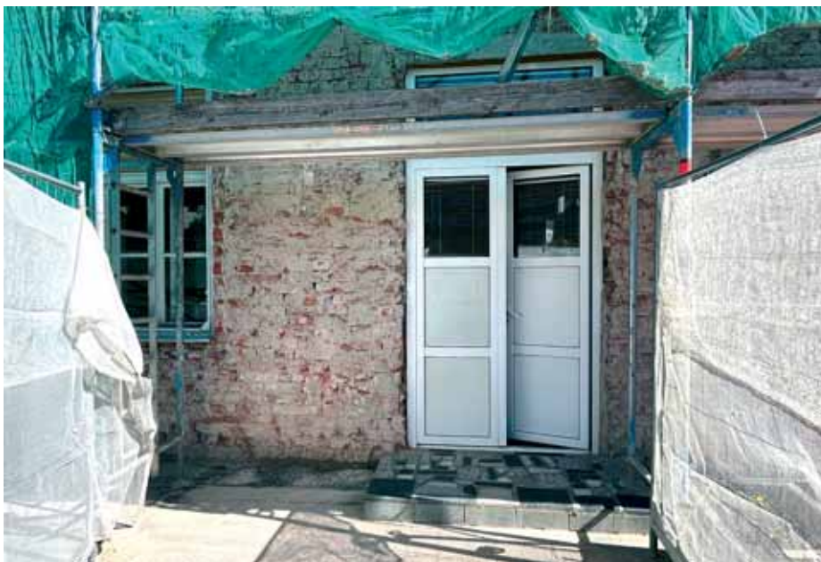
Radovi na obnovi kolodvorske zgrade u Krapini
