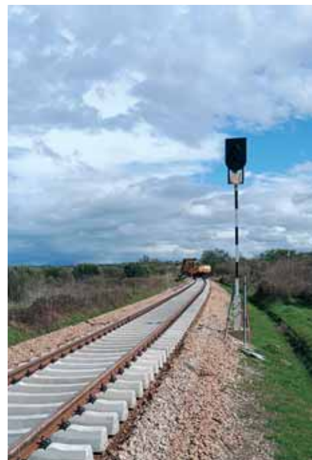
Ugrađeni novi AB pragovi i tračnice
