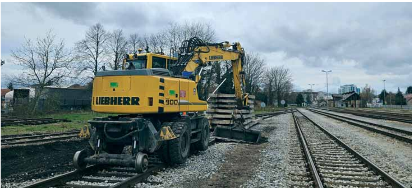
Radovi u kolodvoru Varaždin
