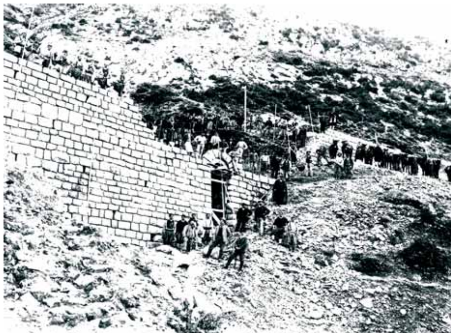
Radovi na potpornom zidu i propustu tijekom gradnje pruge kod Sutorine
