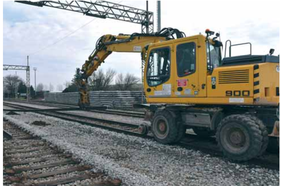
Radovi u kolodvoru Dugo Selo
