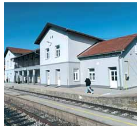
Obnovljeni kolodvor Virovitica
