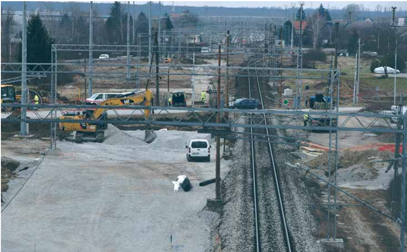
Radovi ispred ulaza u kolodvor Dugo Selo
