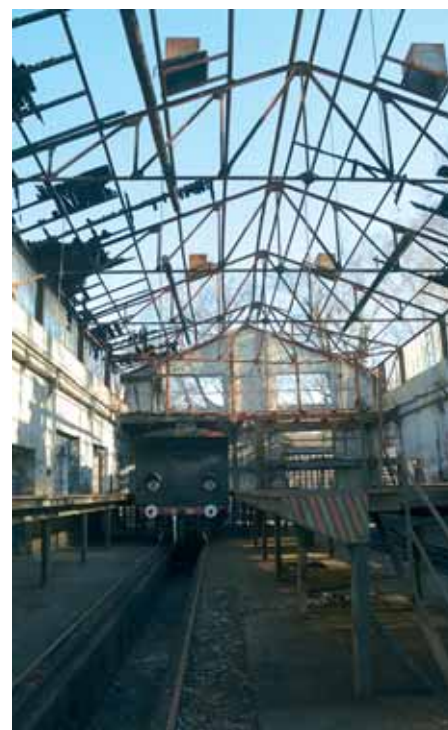
Nekadašnja hala za popravak parnih lokomotiva i lokomotiva serije 51 oštećene u požaru
