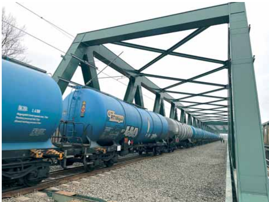
Prelazak prvog teretnog vlaka preko novog mosta Drava
