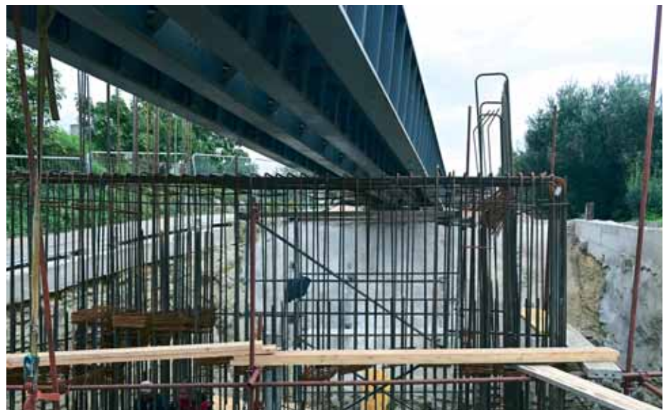
Armatura ispod provizorija
