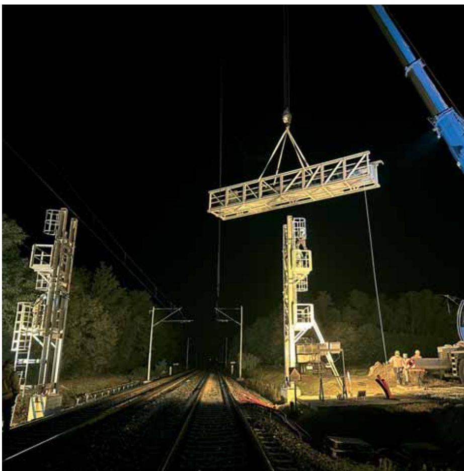
Ugradnja mjerne stanice kod Jankovaca
