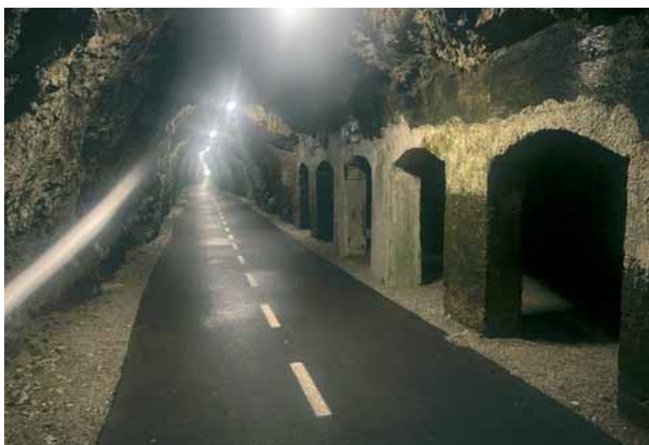
Tunel ispod uzvisine Sv. Mohora
