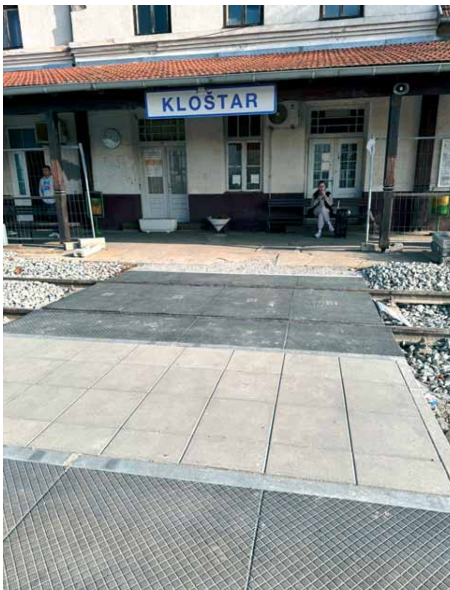
Novo sintetičko popođenje na pješačkom prijelazu prema uređenim površinama
