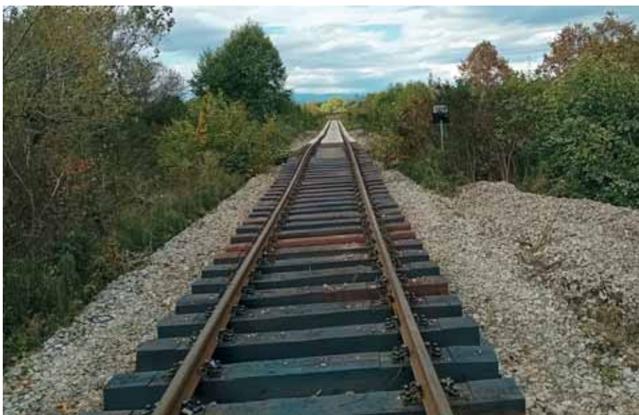
Obnovljena pruga s novim betonskim pragovima
