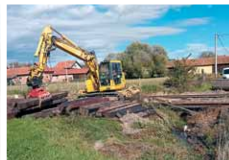
Uklanjanje starih drvenih pragova
