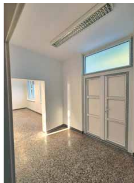
Izvedeni radovi u kolodvoru Bibinje
