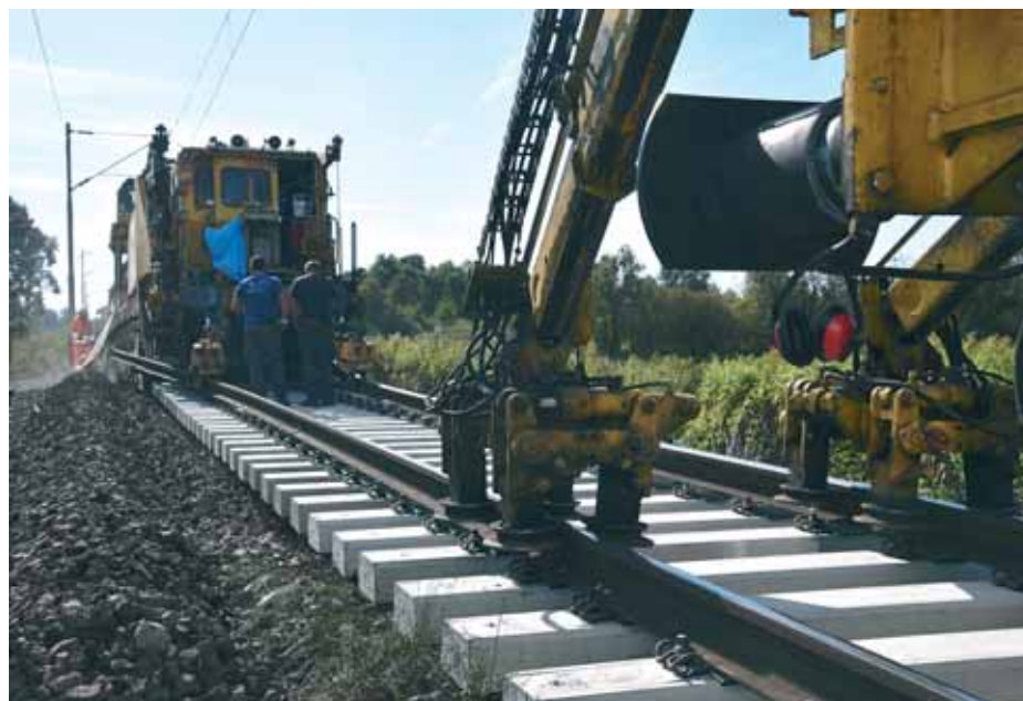
Radovi na obnovi pružne dionice Kutina – Deanovec
