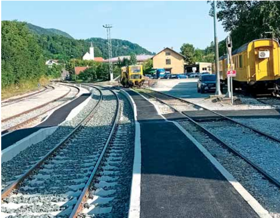
Uređene površine u kolodvoru Krapina
