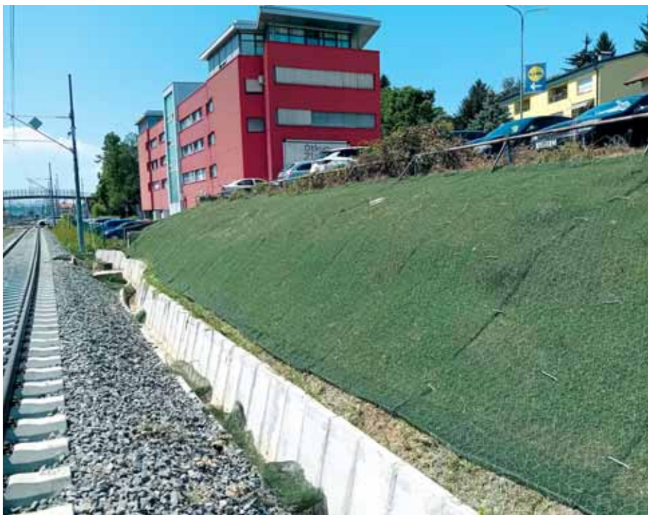
Sanacija pokosa i odvodnje u Zaboku
