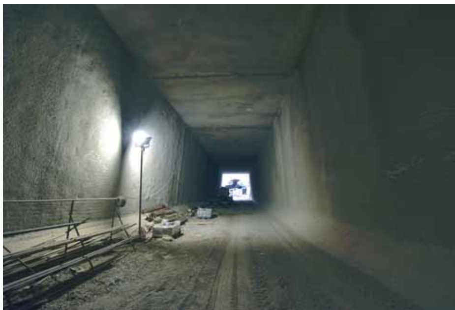
Unutrašnjost vijadukta Glinščica u gradnji
