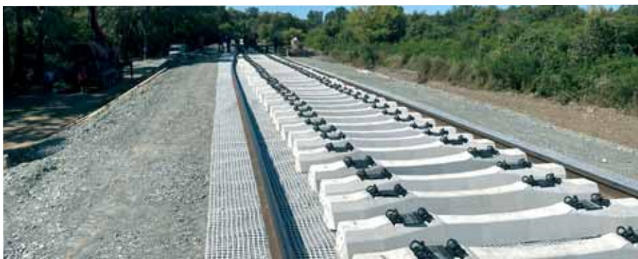
Kolosijek u izgradnji na novome nasipu od km 319+630 do km 319+770
