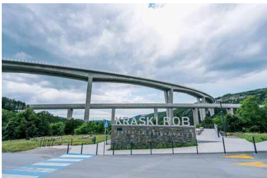
Željeznički vijadukt Gabrovica prolazi između stupova vijadukta autoceste Črni Kal
