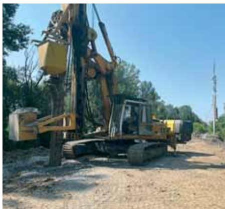
Garnitura za izvedbu šljunčanih stupnjaka od km 318+650 do km 319+050
