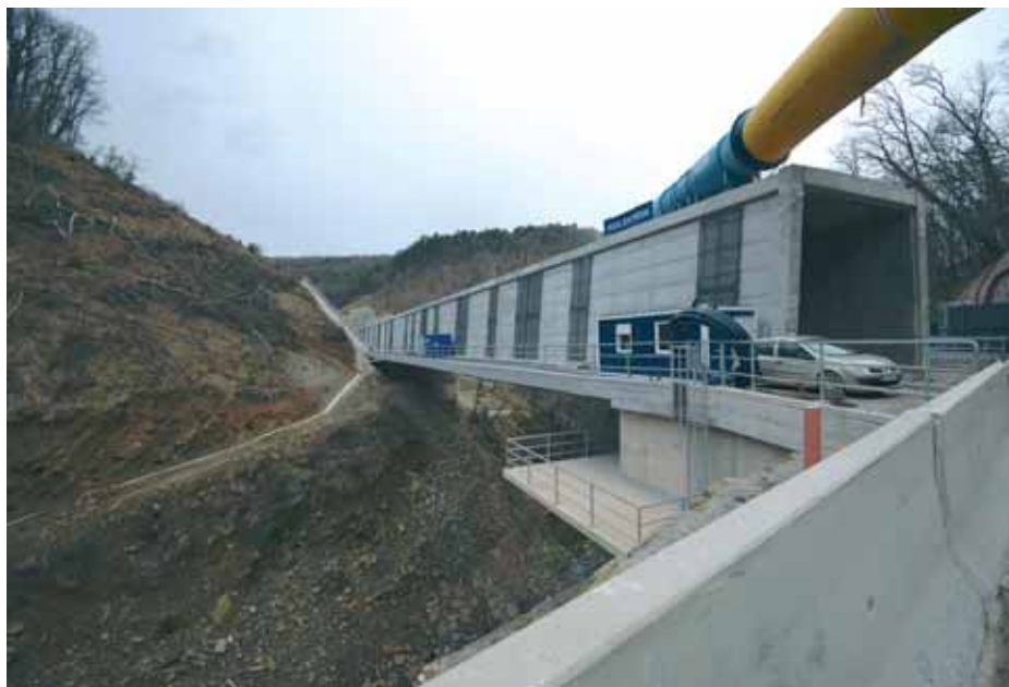
Natkriveni vijadukt Glinščica između tunela T1 i T2
