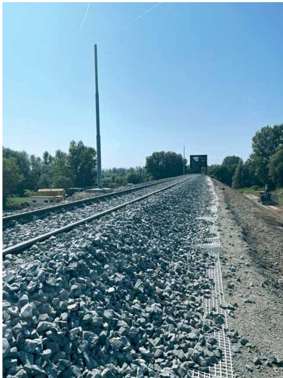
Kolosijek u izgradnji na novome nasipu od km 317+171 do km 317+276
