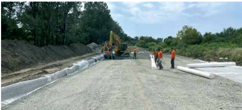
Izvedba prvog sloja nasipa od km 319+630 do km 319+770
