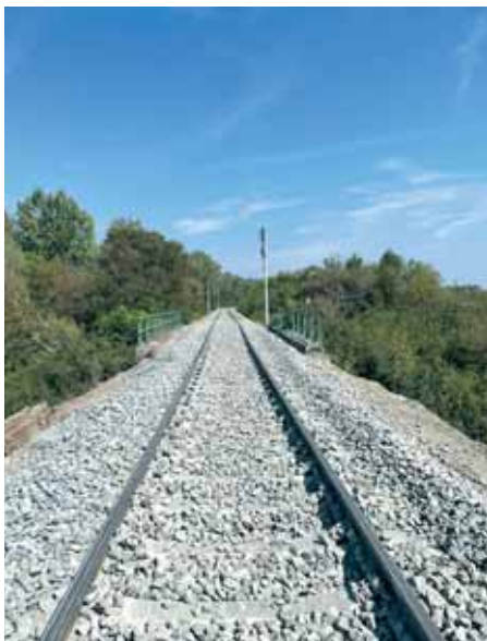
Kolosijek u izgradnji na novome nasipu od km 317+171 do km 317+276
