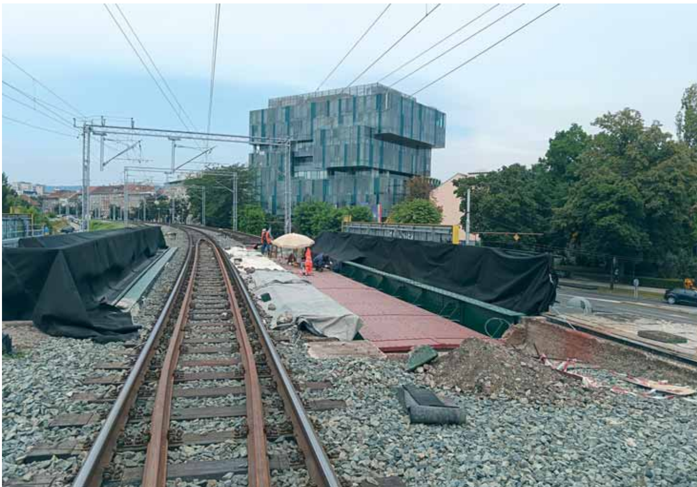
Sanacija nadvožnjaka »Adžijina«
