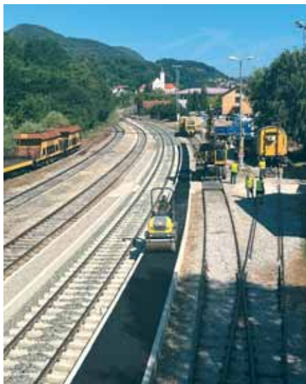
Asfaltiranje perona u kolodvoru Krapina
