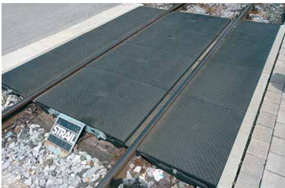
Ugradnja sintetičkog popođenja
