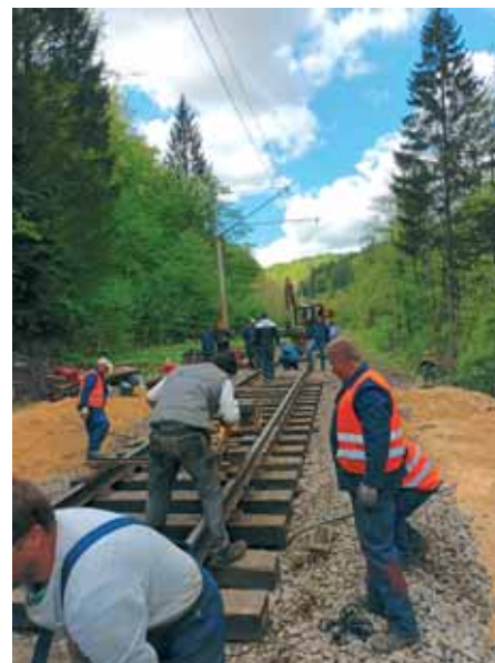
Radovi na uklanjanju provizorija i postavljanju kolosiječne rešetke
