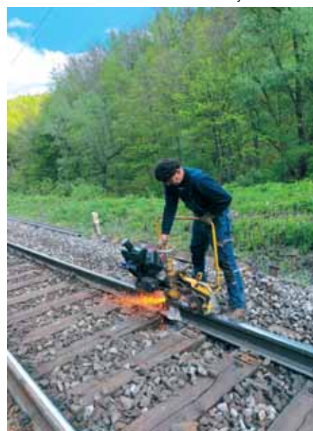
Zavarivanje i brušenje tračnica
