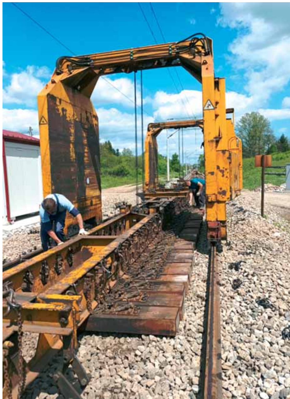
Radovi na zamjeni kolosiječne rešetke portalnim kranom
