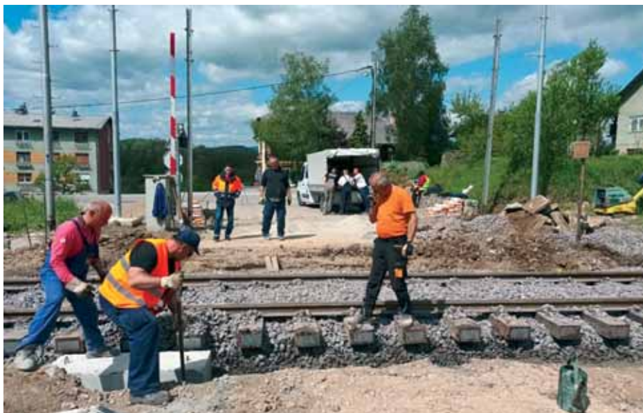
Radovi na zamjeni ŽCP-a, Generalski Stol
