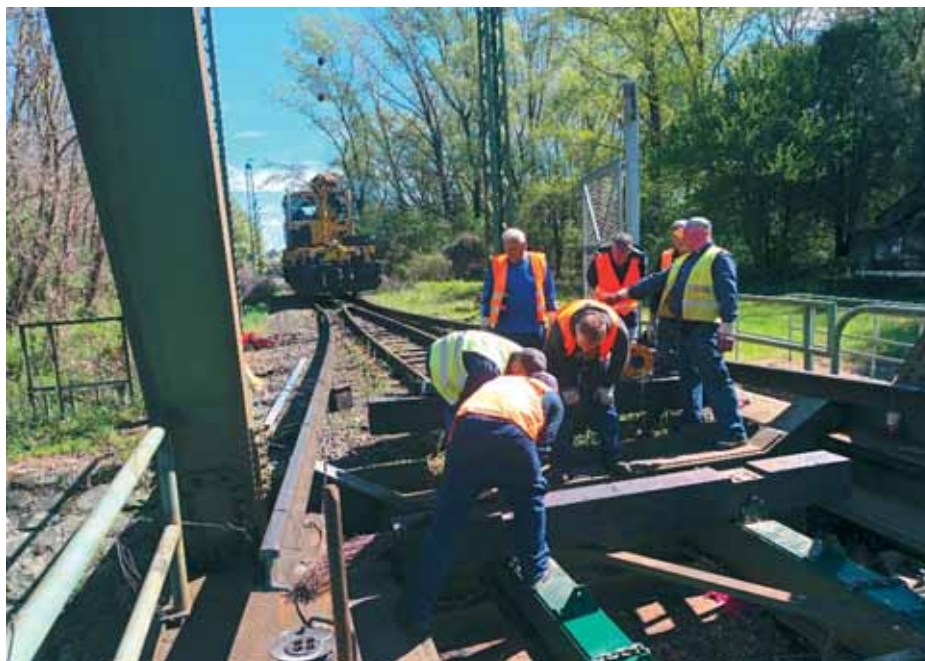
Radovi na mostu Mura
