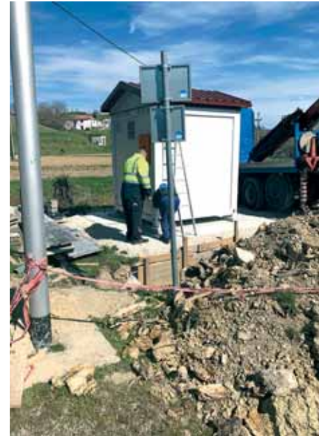
Radovi na ŽCP-u
