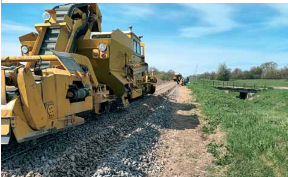
Strojno rešetanje pruge Čakovec – Macinec – DG
