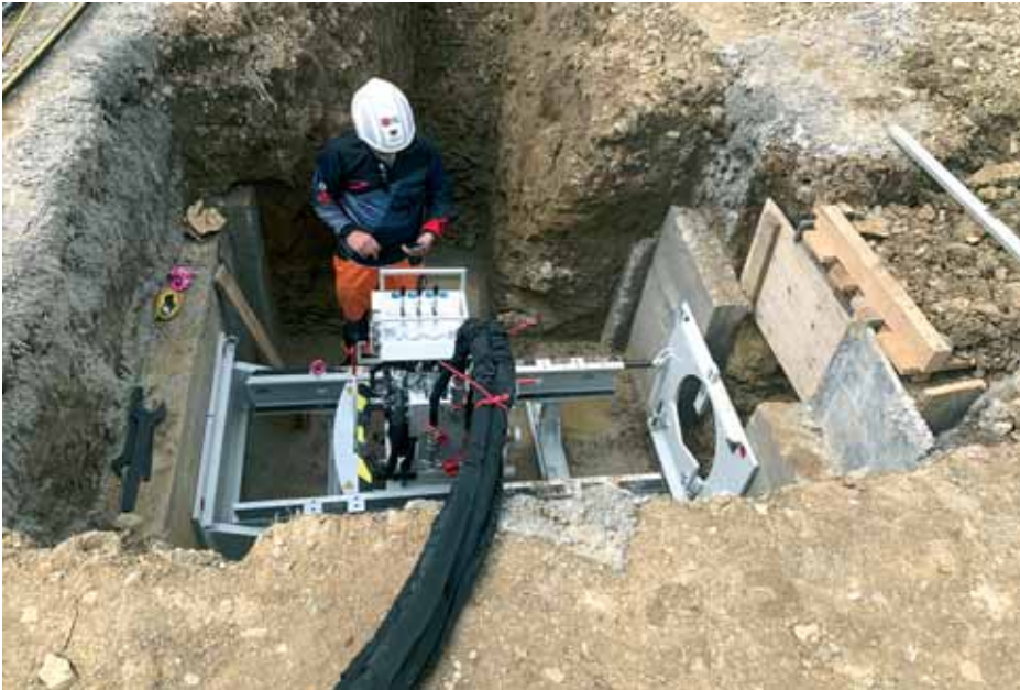
Radovi na ŽCP-u
