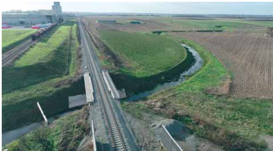
Novi most Bobotski kanal te zidovi za zaštitu od buke
