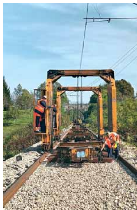
Zamjena kolosiječne rešetke portalnim kranovima
