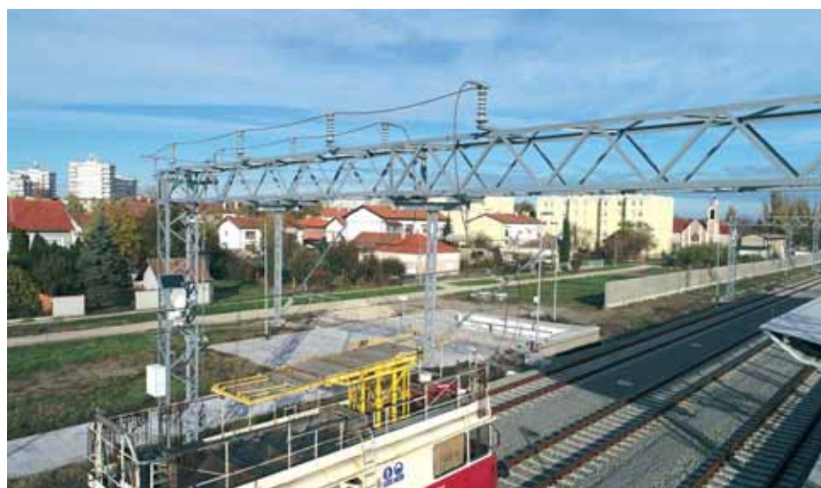
Završni radovi na kontaktnoj mreži u kolodvoru Vukovar-Borovo naselje
