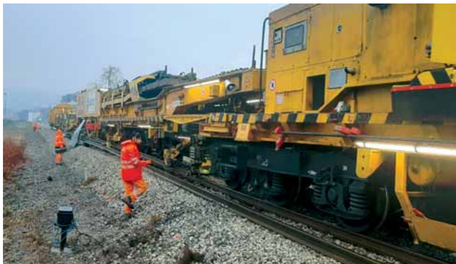
Postrojenje za izmjenu kolosiječne rešetke
