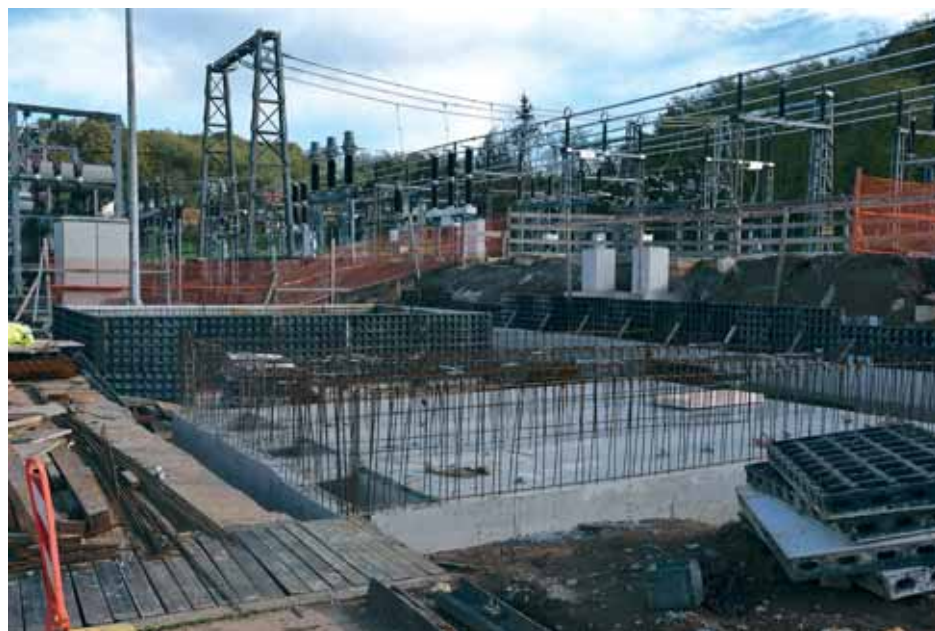
Elektrovršno postrojenje Mrzlo Polje (temelji transformatora)
