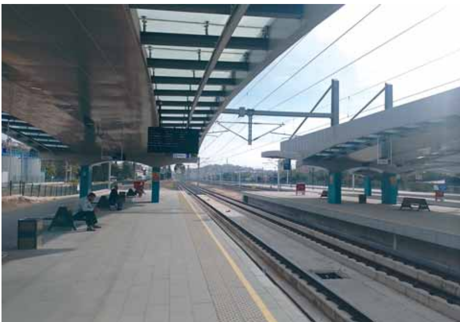
Pogled s perona željezničkoga kolodvora Gaziantep
