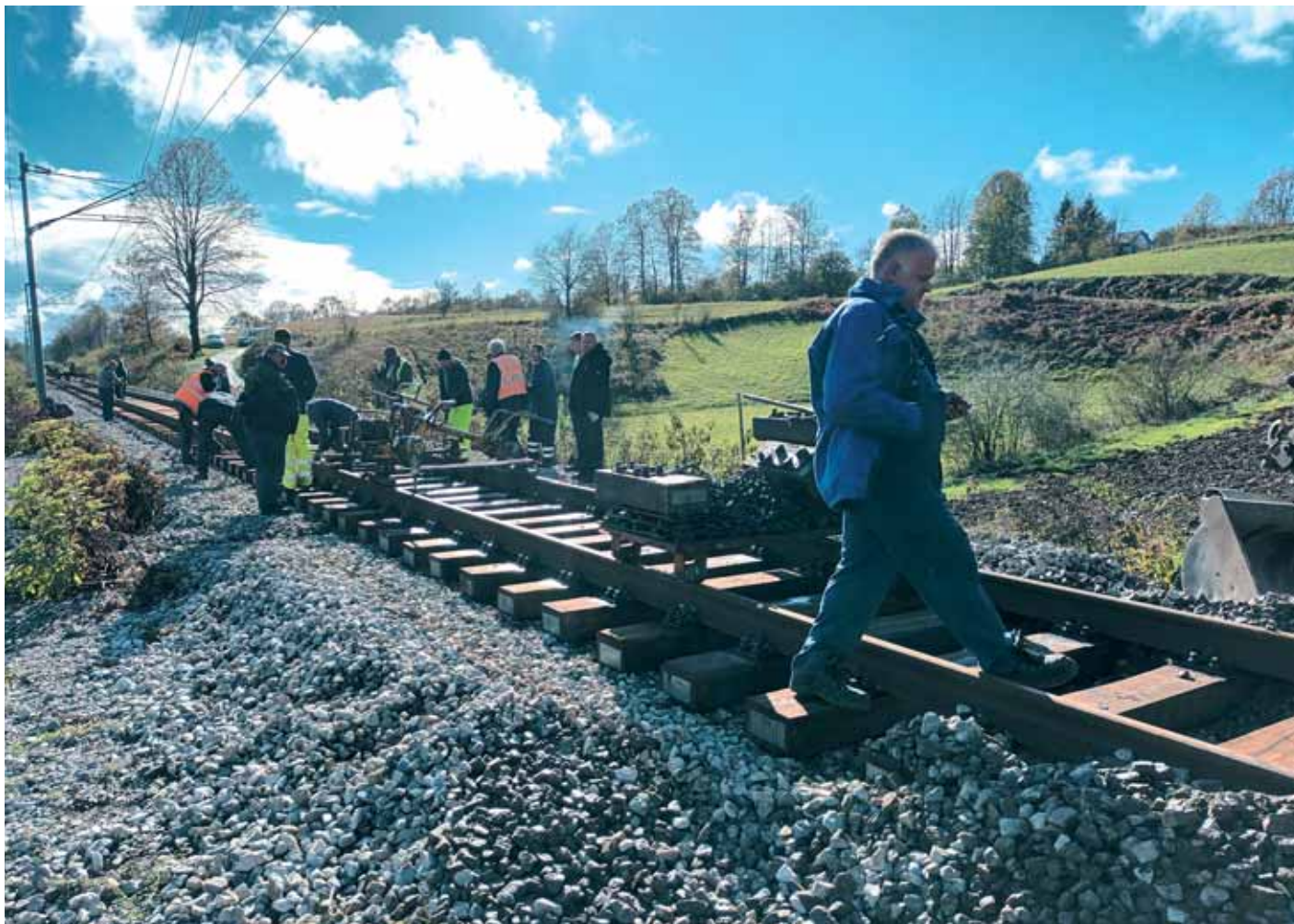
Montaža novih tračnica UIC60 na nove drvene pragove
