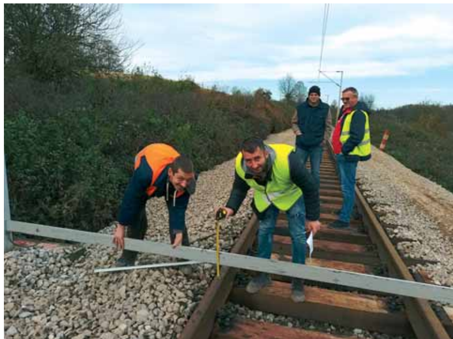
Izmjera izvedenog kolosijeka
