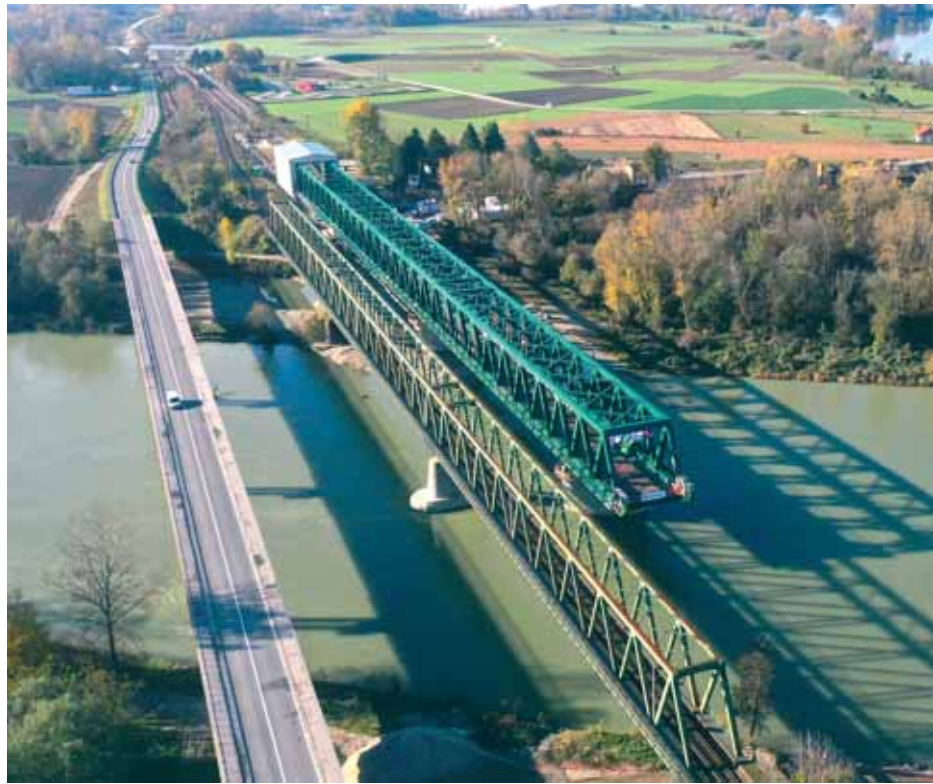
Naguravanje novog mosta Drava
