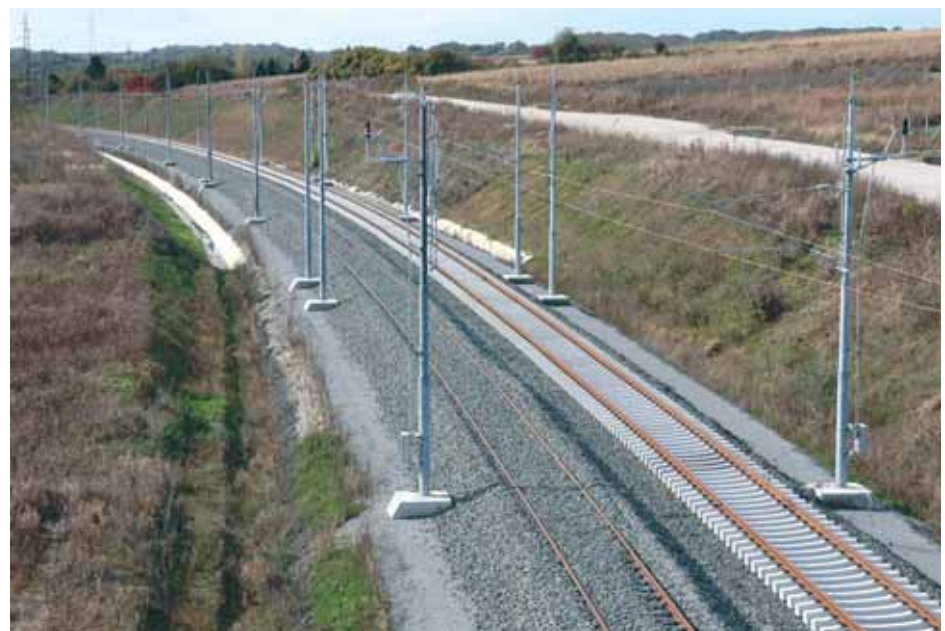
Pogled s novoizgrađenog nadvožnjaka Križevci
