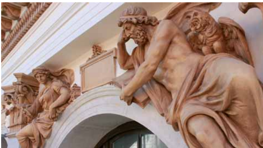
Detalji restauracije riječkog kolodvora
