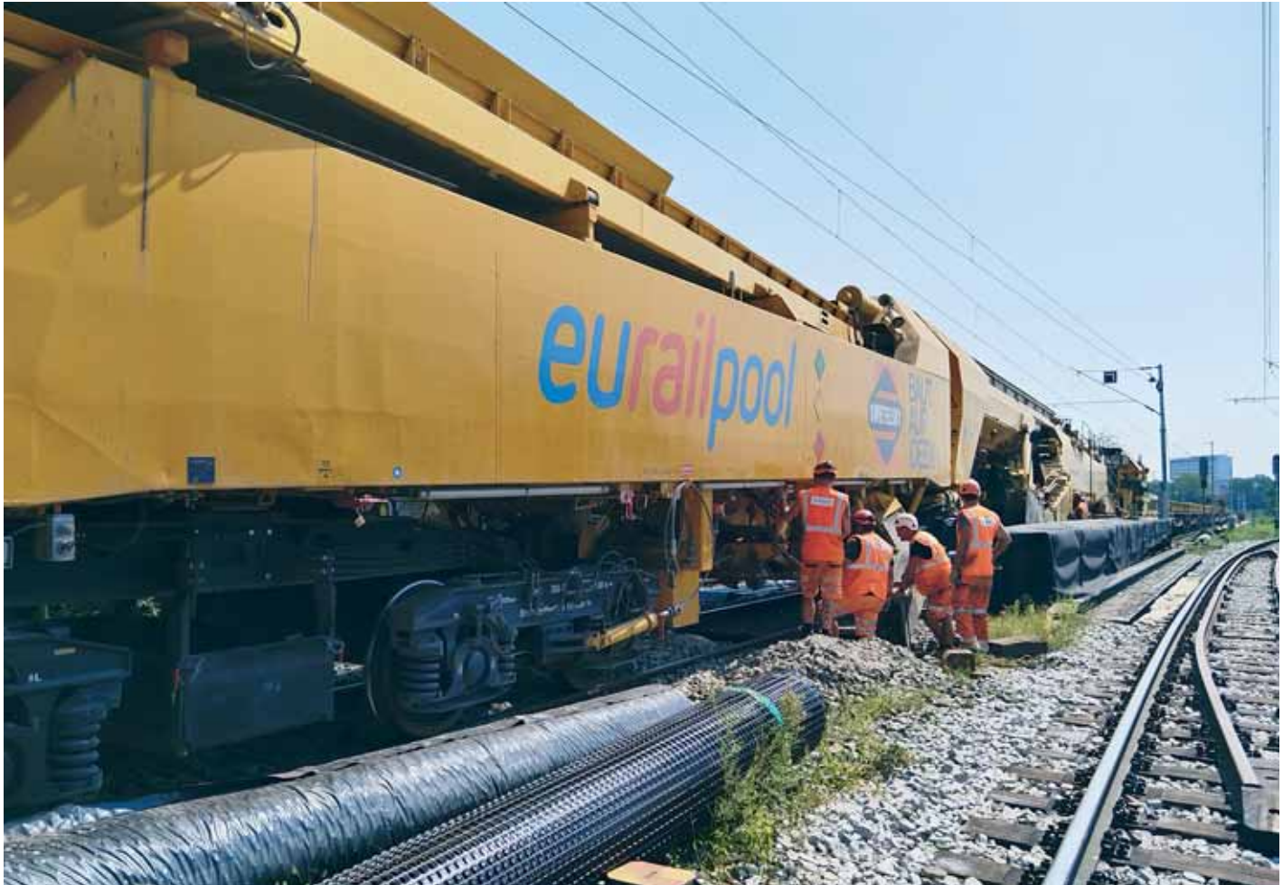
AHM-800 postrojenje je za iskop i ugradnju zaštitnoga tamponskog sloja.
