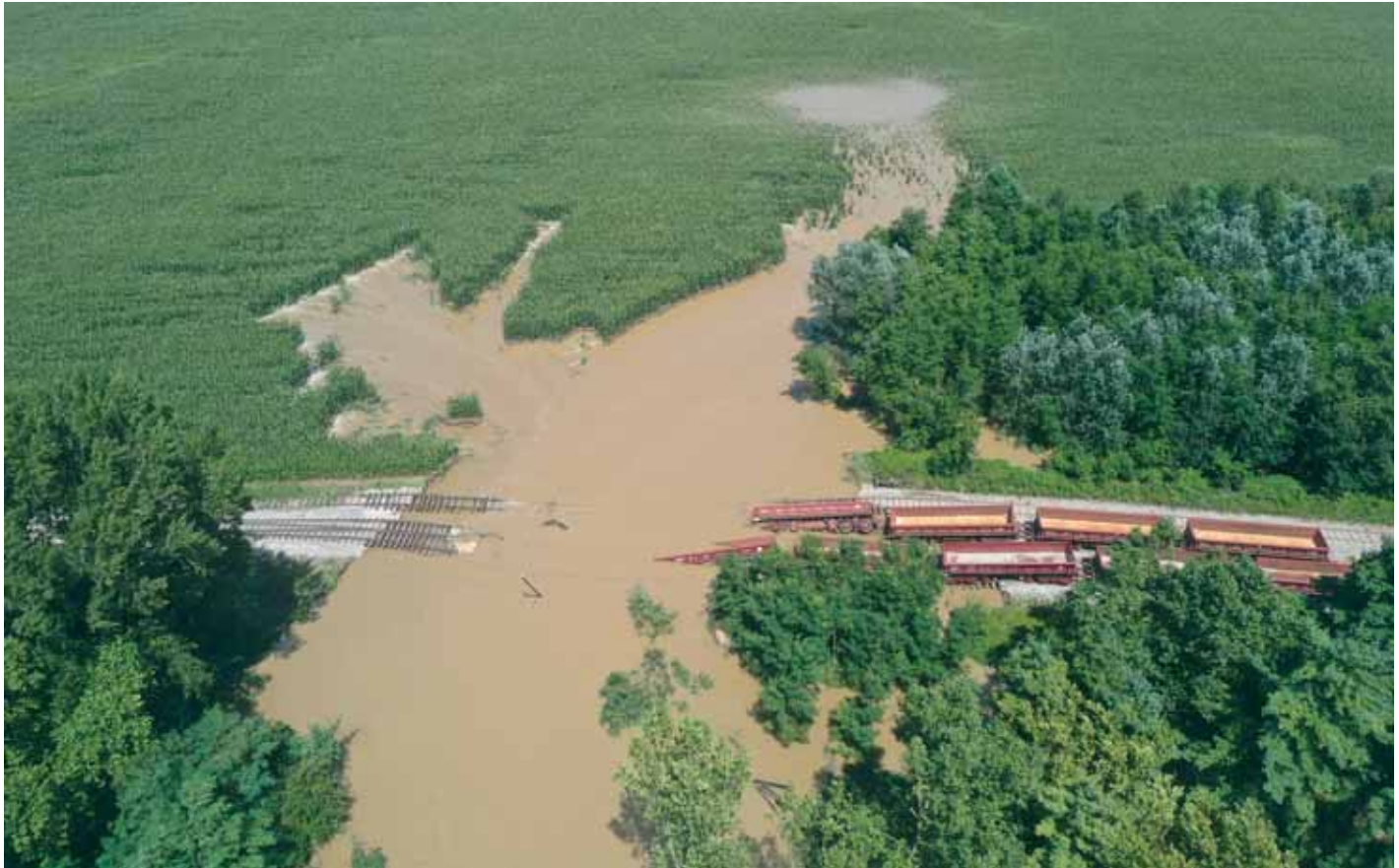
Teretni dio kolodvora Botovo zahvaćen poplavom
