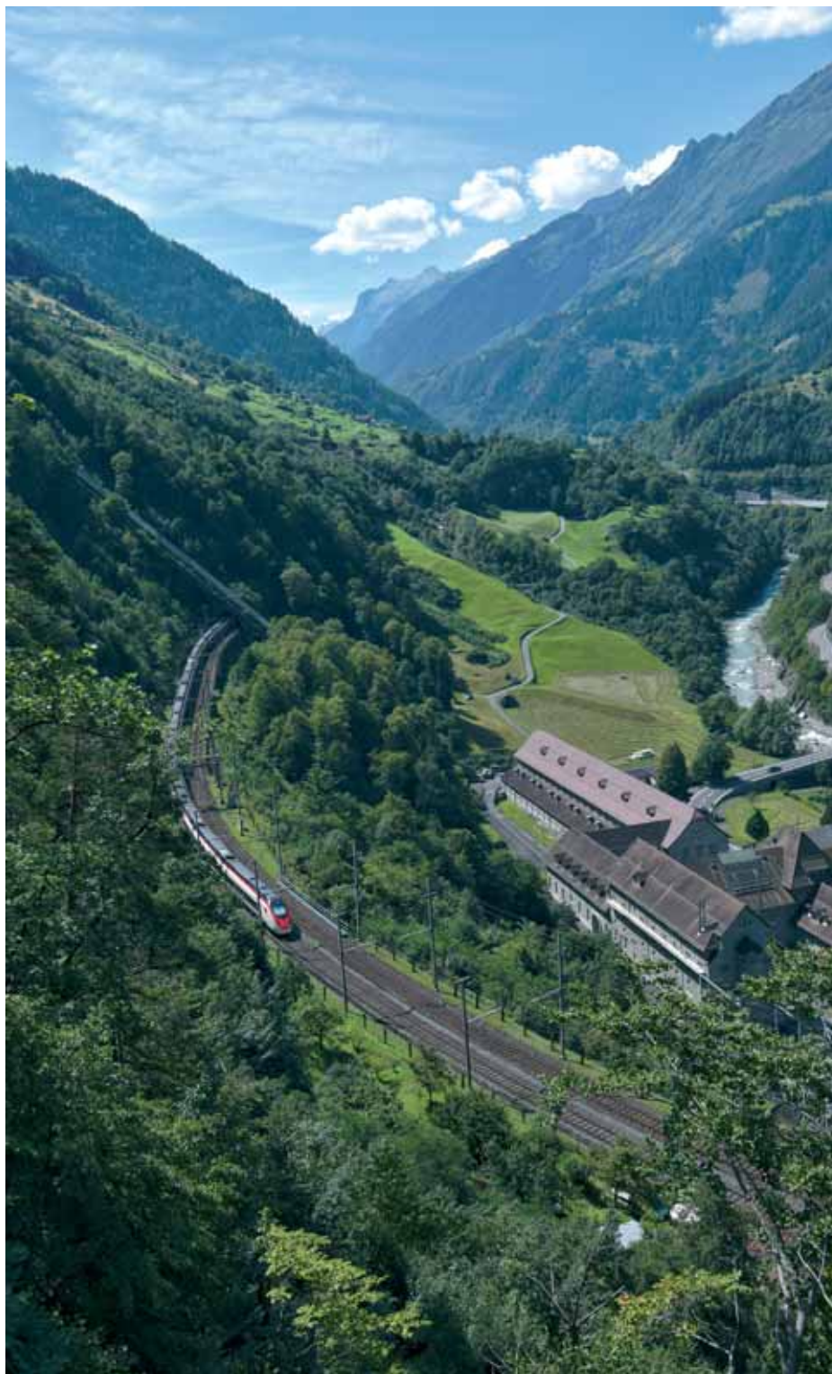
IC vlak prolazi pokraj električne centrale Amsteg na putu prema kantonu Ticinu
