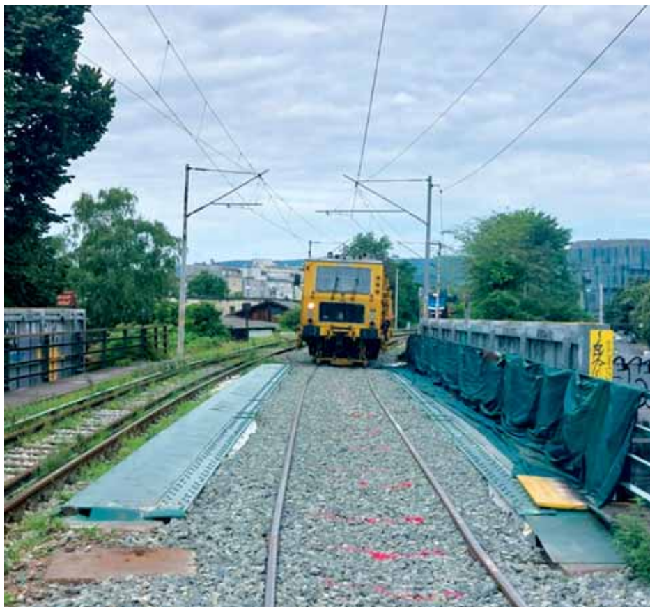
Radovi na podvožnjaku »Savska«
