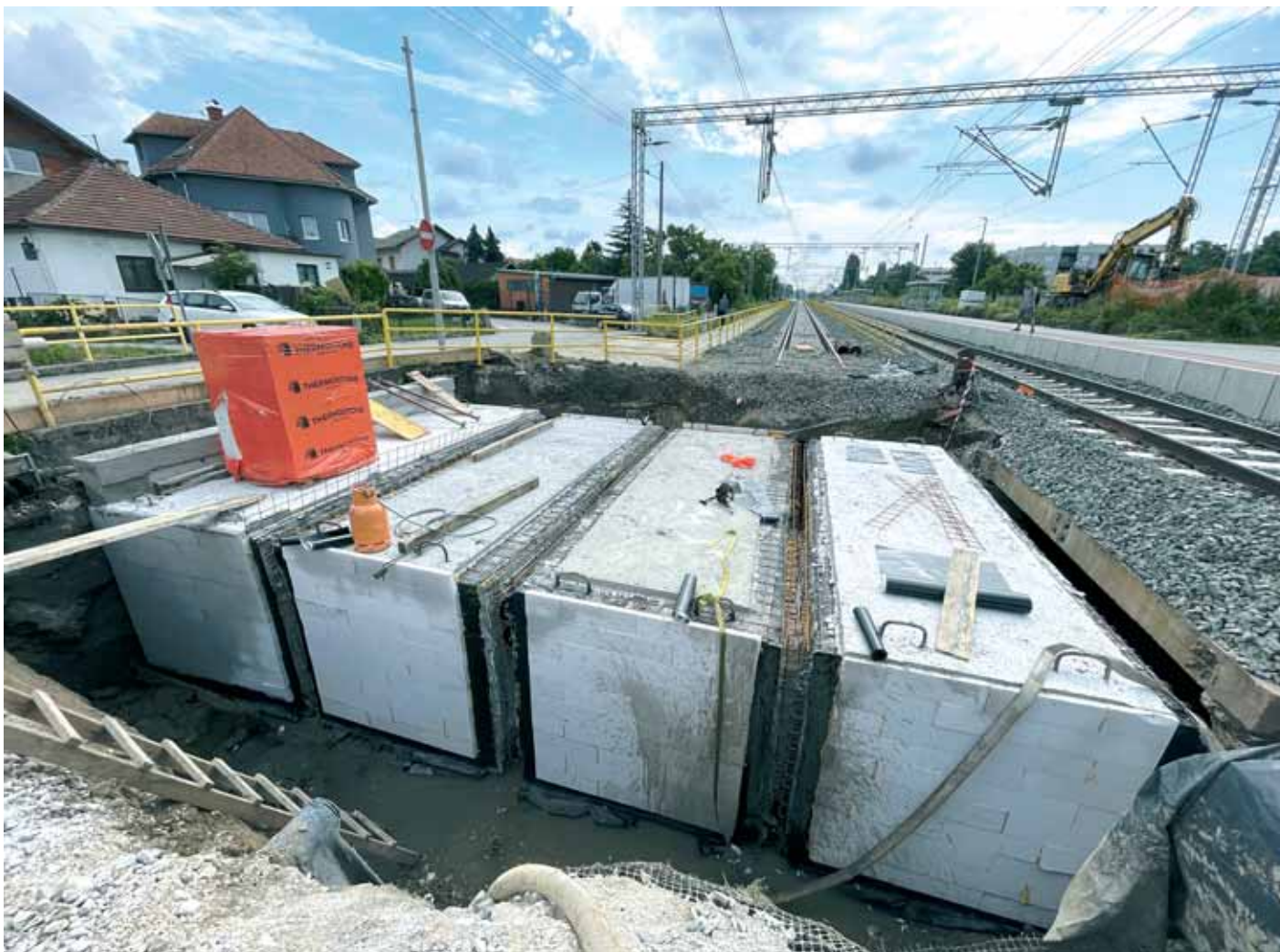
Radovi na propustu »Kustošak«
