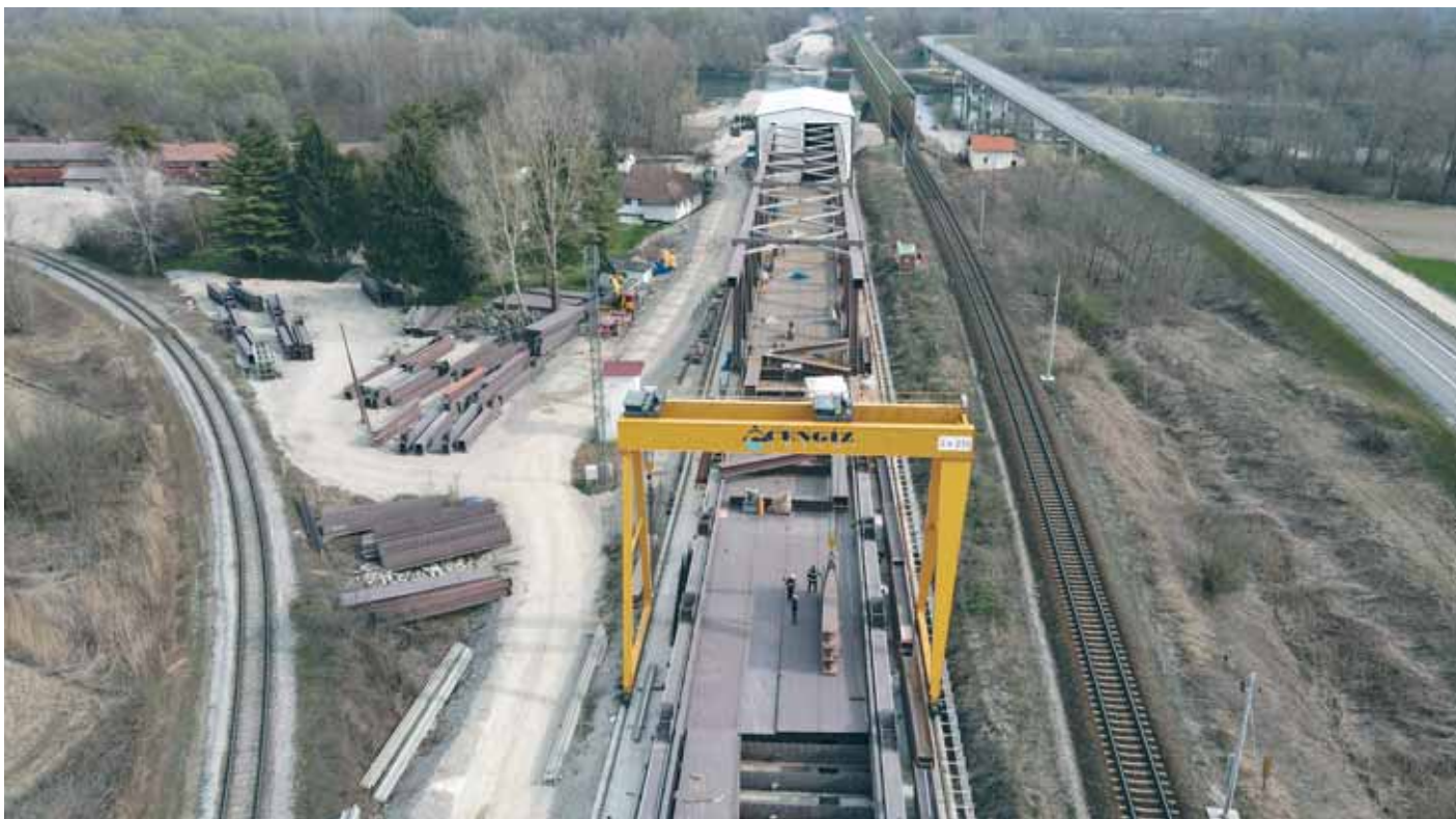
Novi most imat će dva kolosijeka, bit će dug 300 metara, a visok i širok 10 metara.
