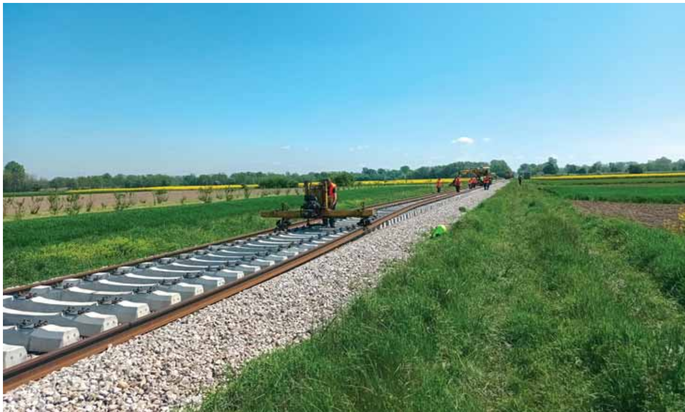
Novo tračnice i armiranobetonski pragovi
