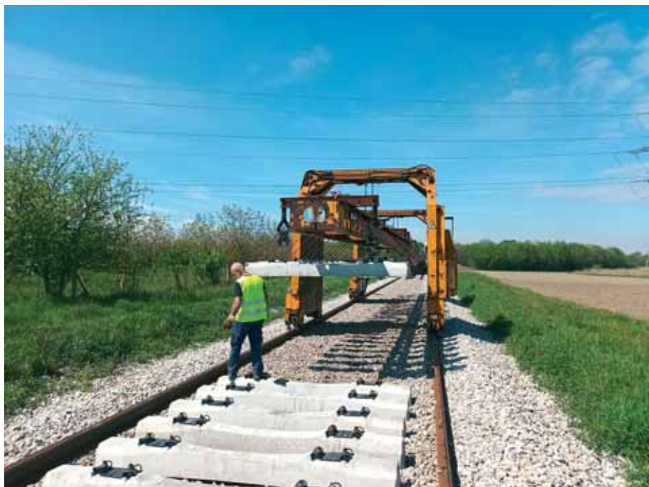
Postavljanje novih armiranobetonskih pragova
