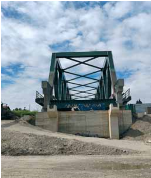
Most se na obali varenjem sklapa u rešetkastu čeličnu konstrukciju, a potom »gura« prema naprijed.
