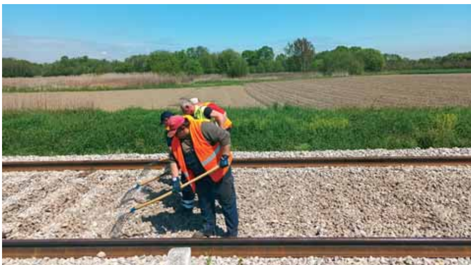
Radovi u tijeku
