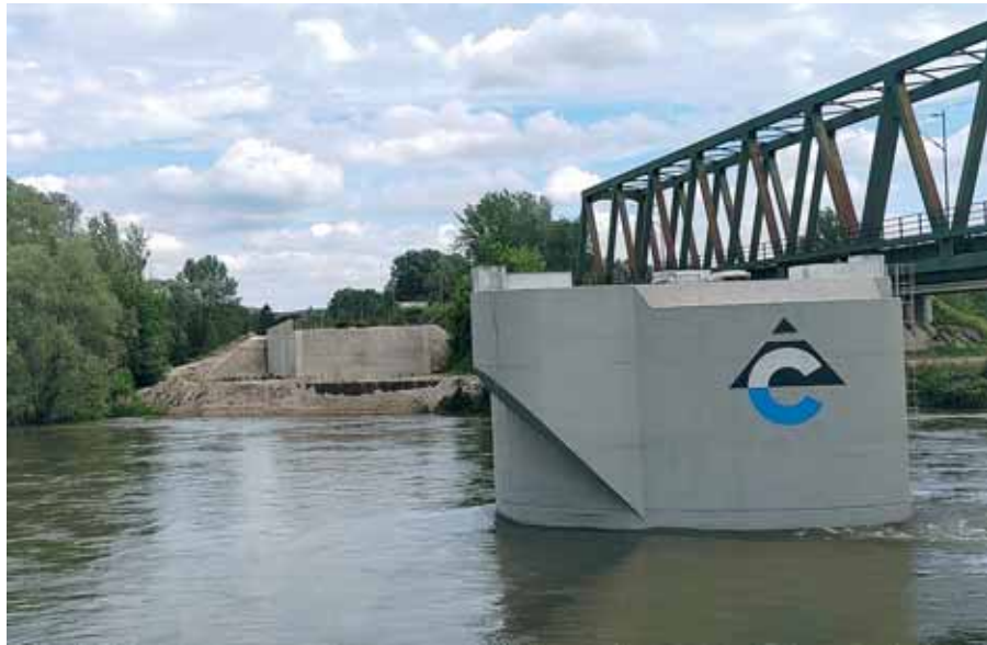
Protezat će se preko dva stupa koji su već izgrađeni u koritu rijeke Drave i dvaju upornjaka.
