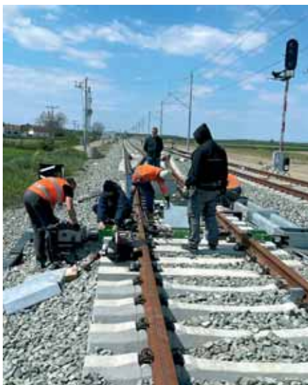
Ugradnja elektropostavne sprave
