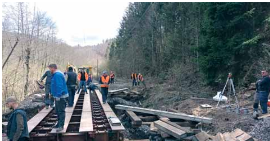
Ugradnja 14-metarskog tipskog željezničkog provizorija na propustu u km 557+133
