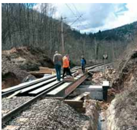
Ugrađen 14-metarski željeznički provizorij radi izgradnje novog propusta u km 558+490
