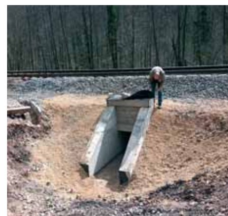
Izgrađen novi propust u km 558+601
