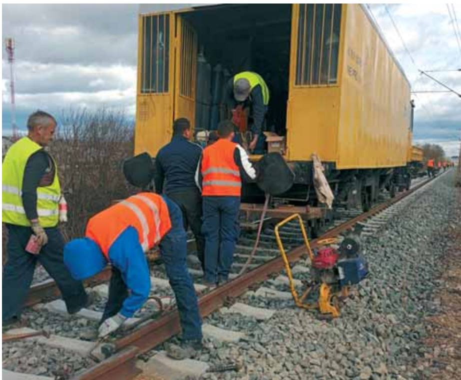
Varenje tračnice
