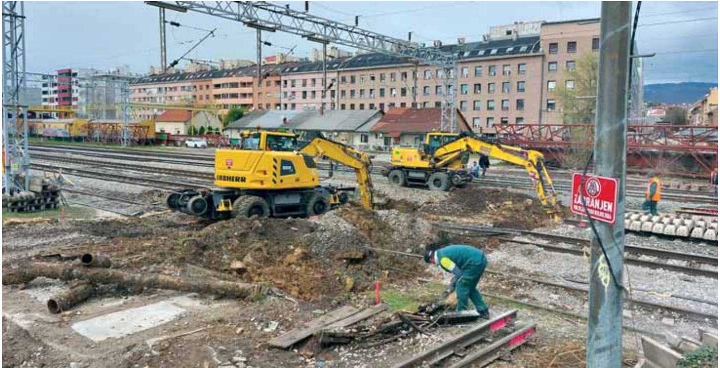
Radovi na obnovi pruge Zagreb Zapadni kolodvor – Zagreb Glavni kolodvor
