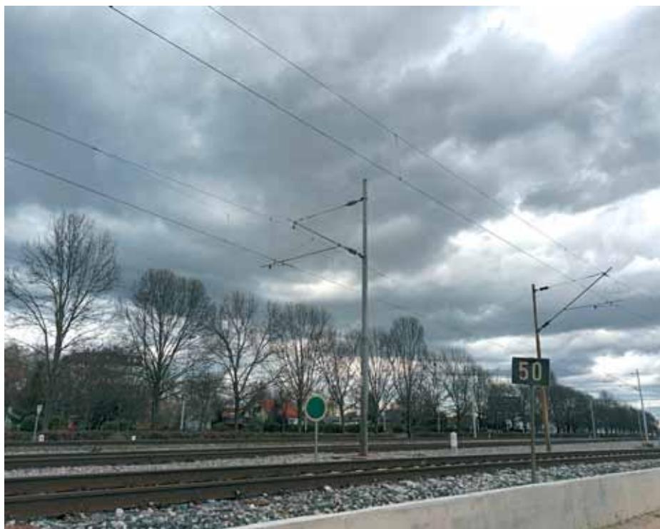
Potporni zid uz kolosijek pri stajalištu Čulinec
