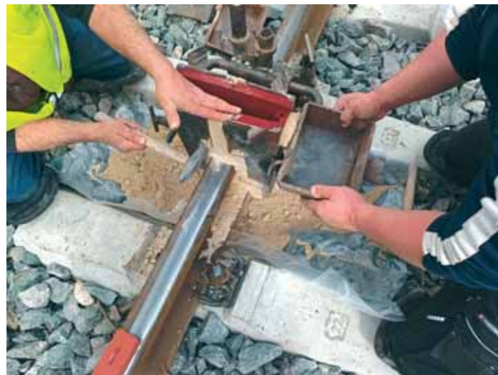
Pripremni radovi za završno zavarivanje tračnice
