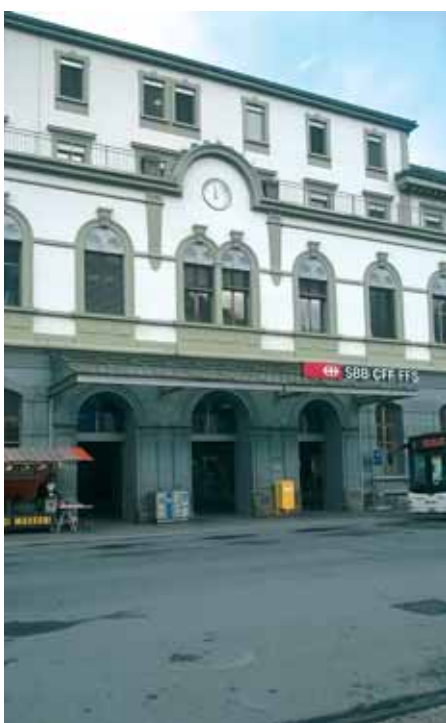
Željeznički kolodvor Brig
