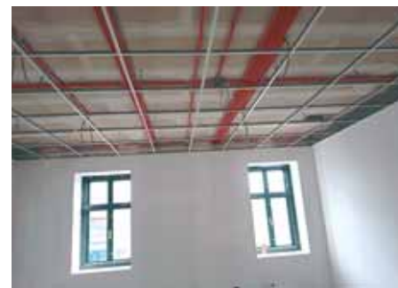
Detalj unutarnje obnove
