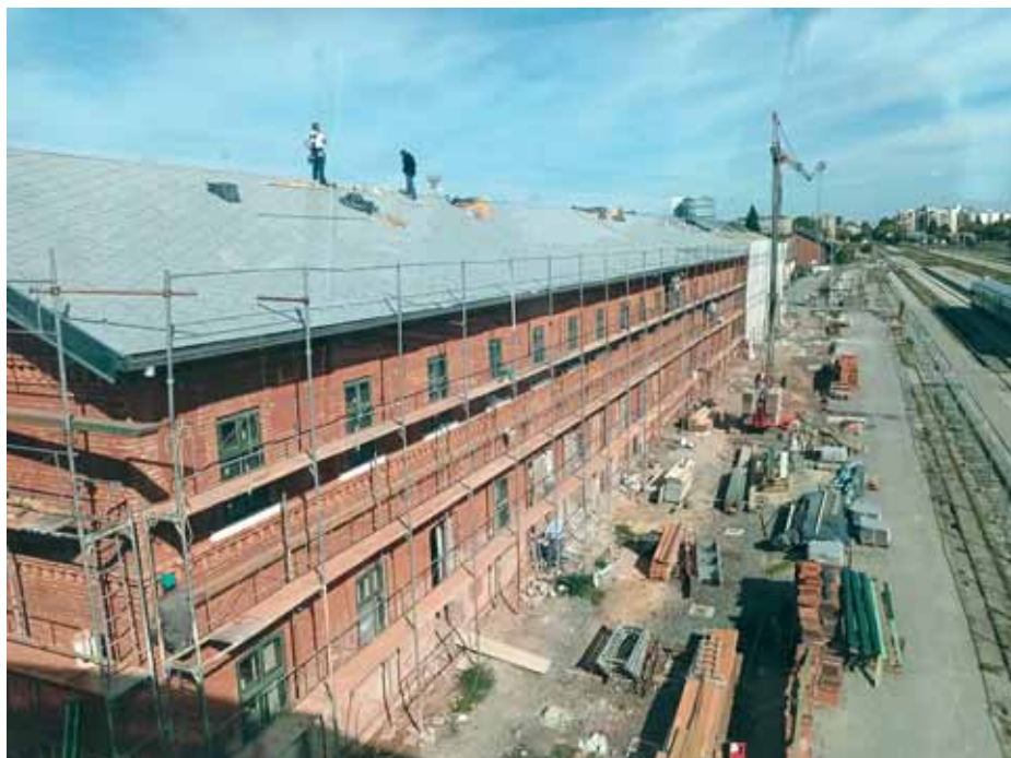
Gradilište kolodvora Osijek u punom pogonu
