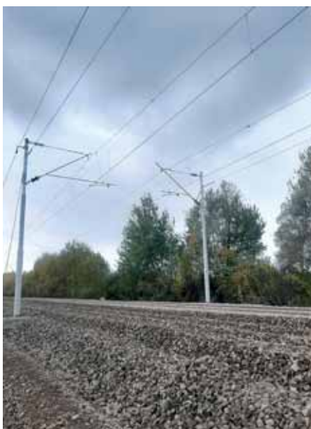
Stari Mikanovci - radovi u tijeku
