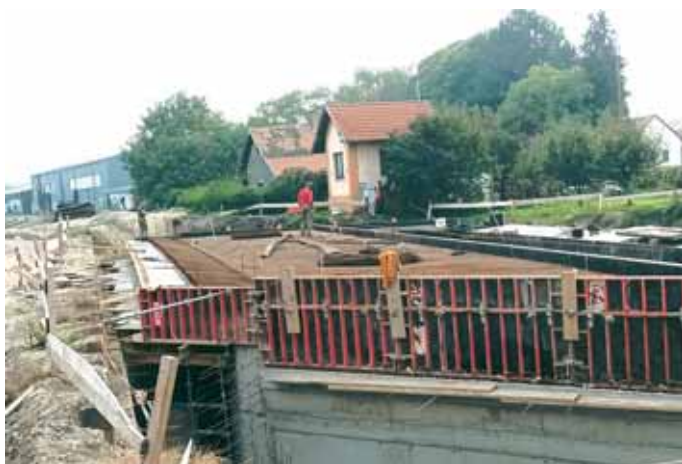
Željeznički most na podvožnjaku Čepinske ceste
