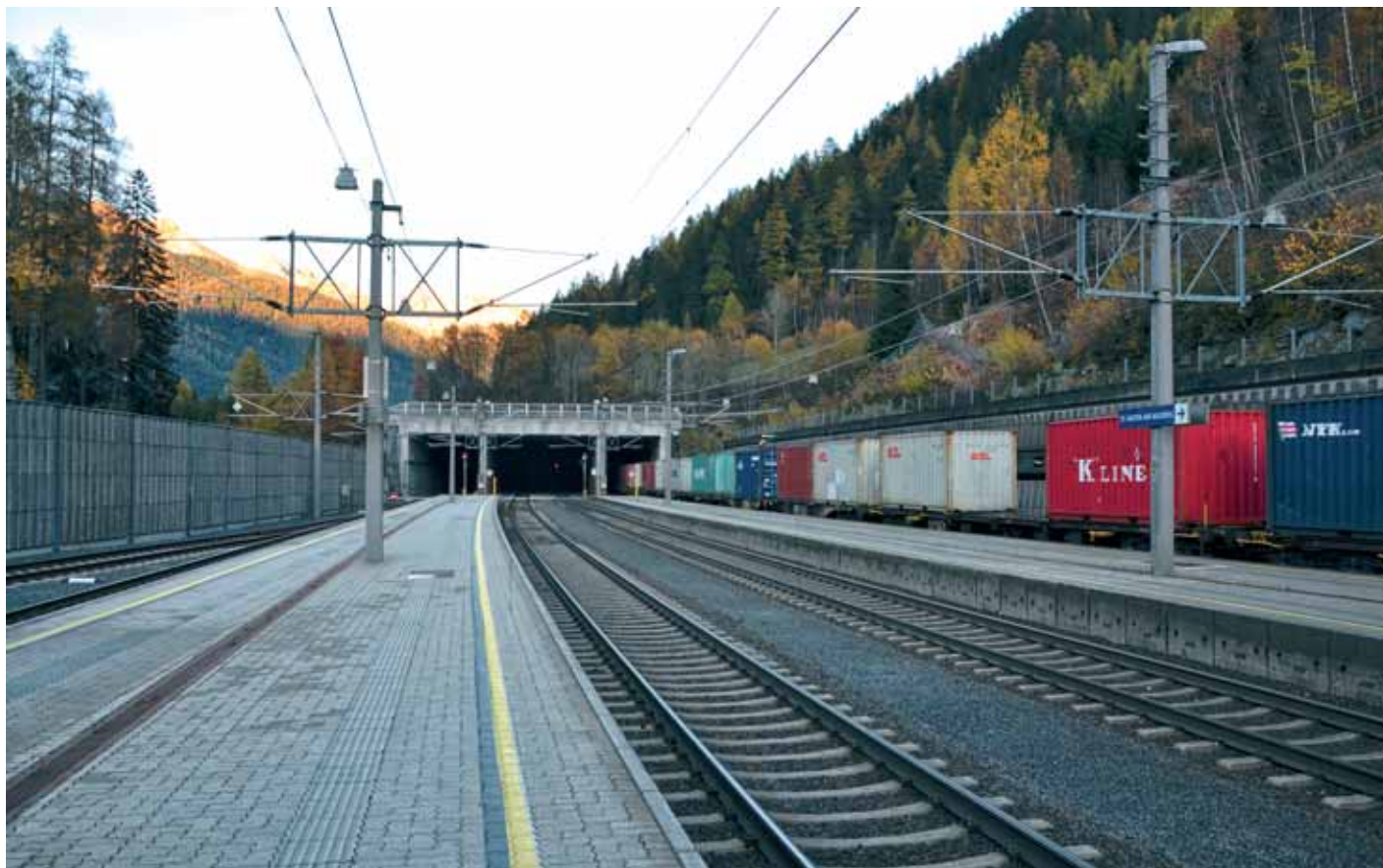
Istočno od kolodvora St. Anton am Arlberg 2001. sagrađen je novi dvokolosiječni tunel kojim je ukinut zavojit dio pruge kroz gradić St. Anton
