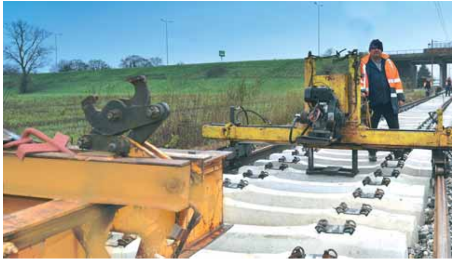
Ilija Jurić, rukovatelj strojem za dizanje tračnica u dugi trak
