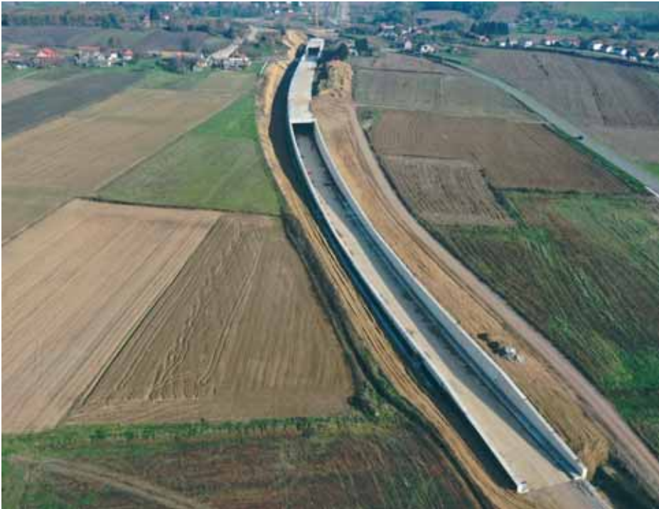
Nadvožnjaci Lepavina 1 i Lepavina 2
