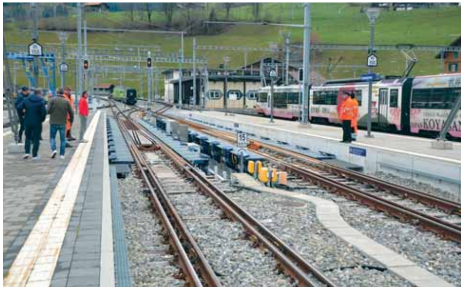
Uređaj za promjenu kolosiječne širine u Zweisimmenu
