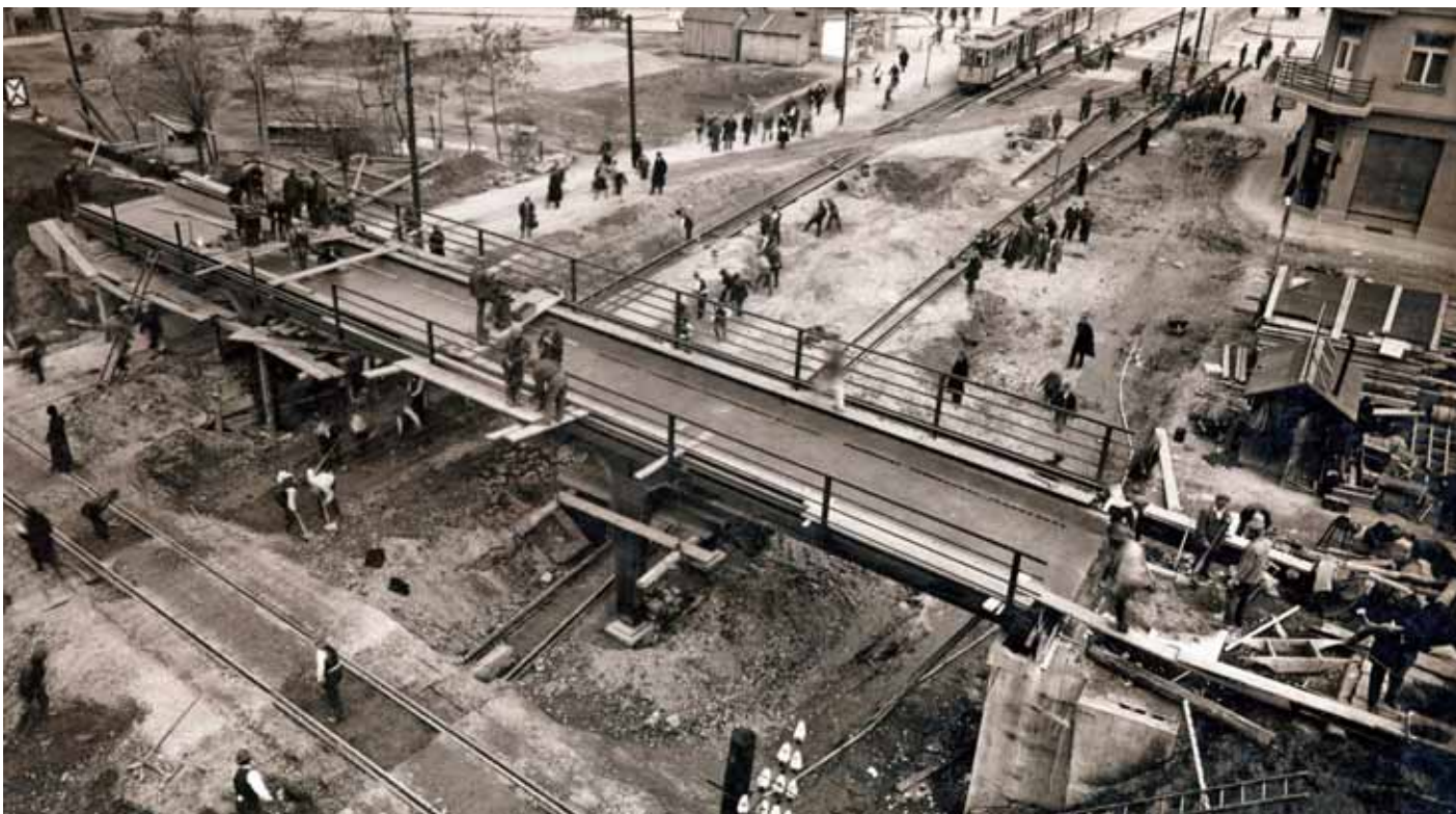
Wagner Biró A.G. Izgradnja nadvožnjaka preko Savske ceste, 1928. Hrvatski željeznički muzej; Zbirka fotografija
