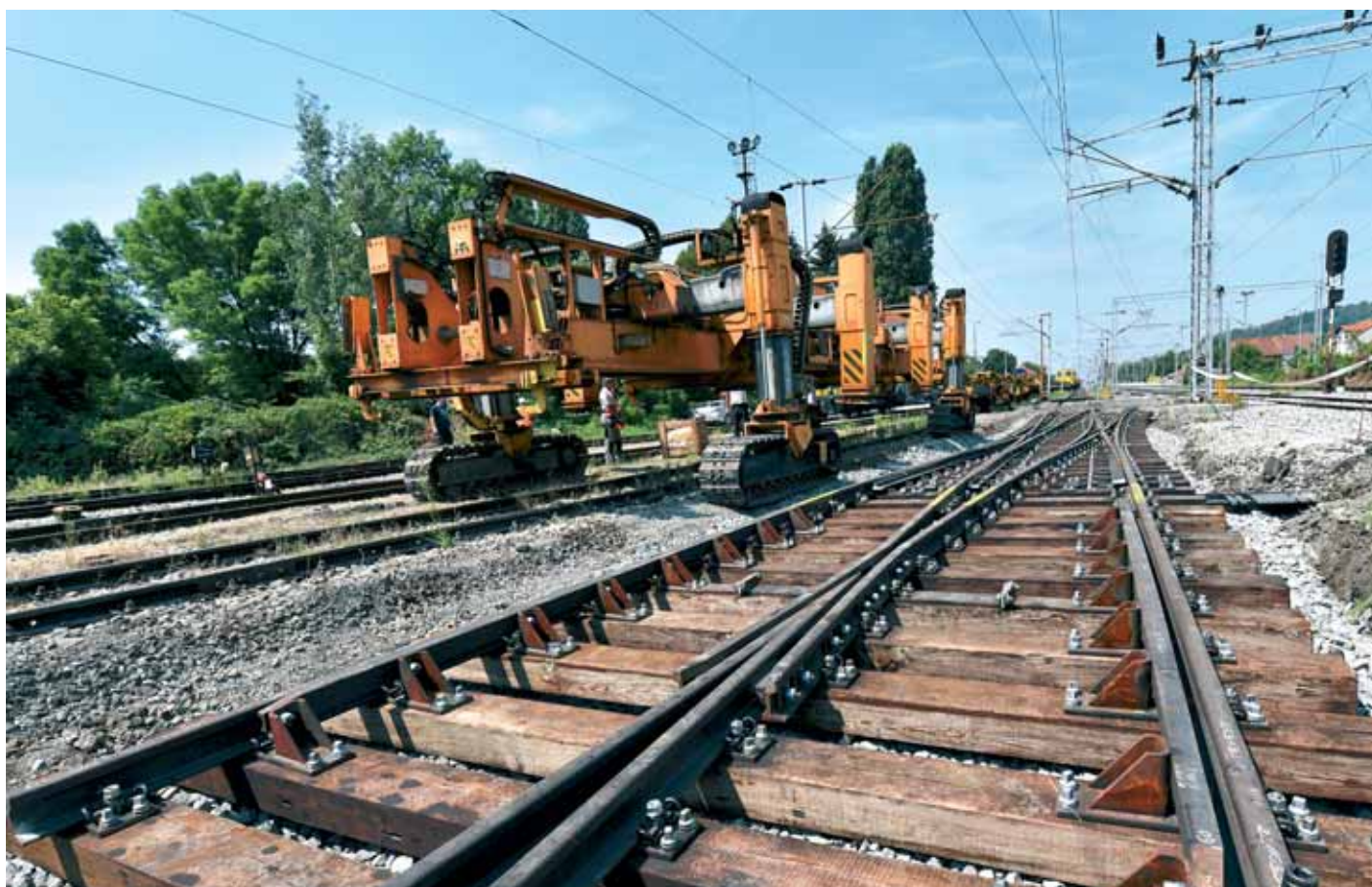
Pomicanje stroja za montažu skretnica nakon obavljenog posla
