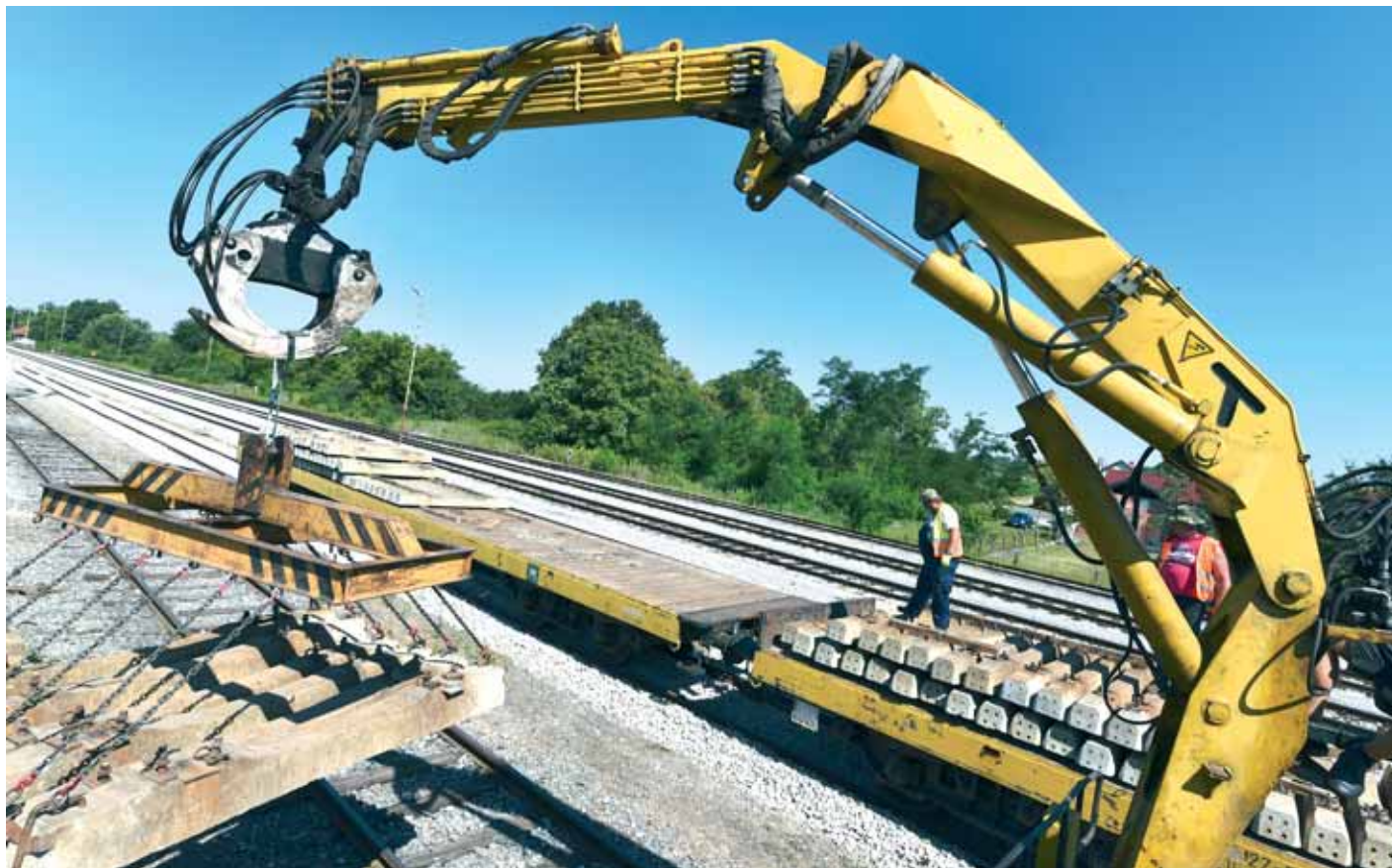
Prebacivanje betonskih pragova na vagon u kolodvoru Kotoriba
