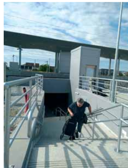
Pješačinja na izlazu iz pothodnika
