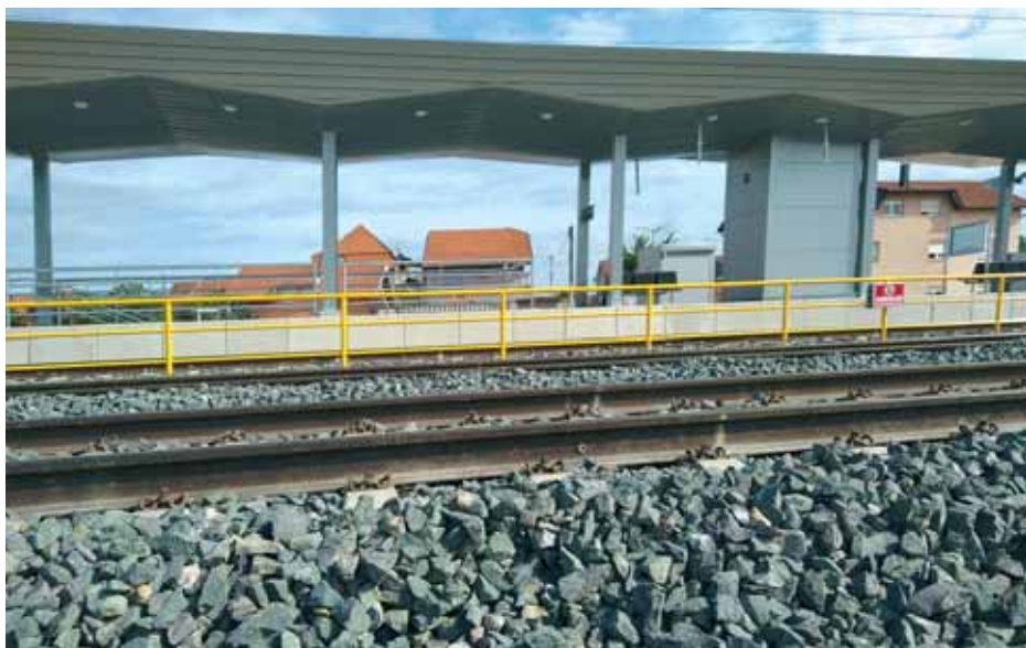
Valovita krovna konstrukcija
