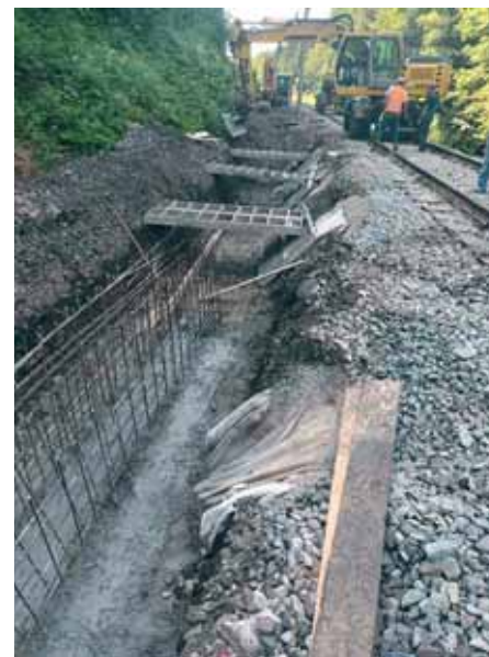
Obnova nasipa Sušica
