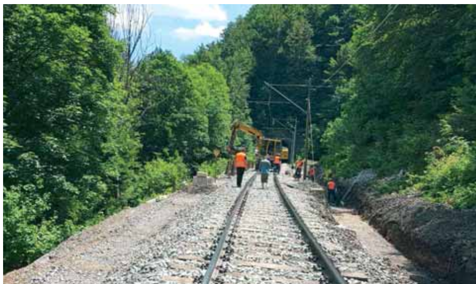
Obnova nasipa Sušica
