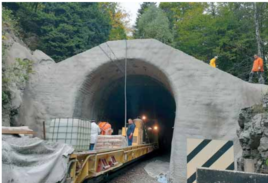
Obnova tunela Bukovac
