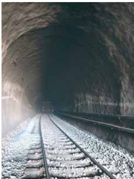
Pogled na završene radove u tunelu
