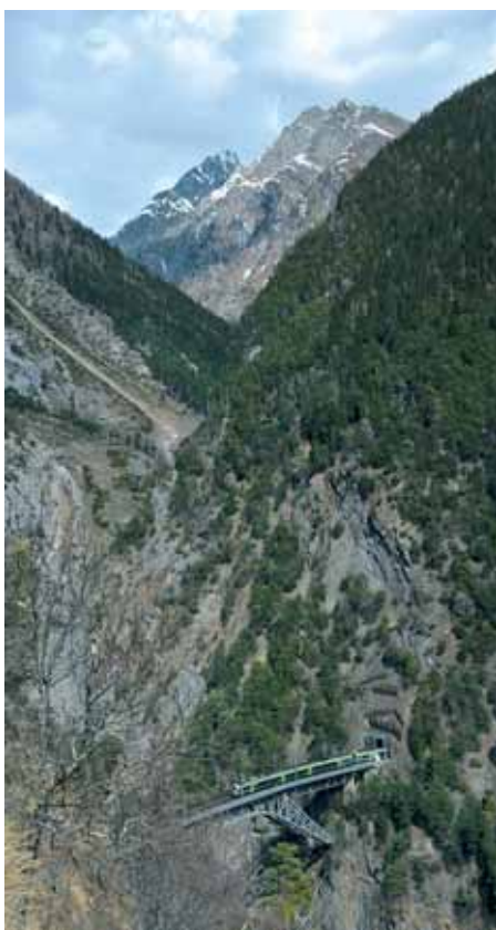
Vlak RABe 535 na čeličnome mostu Bietschtal
