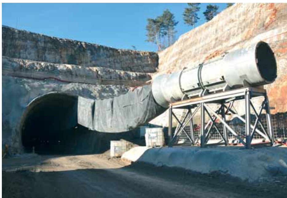
Ulazni portal tunela Lokev, najsjevernijega na trasi 2TDK
