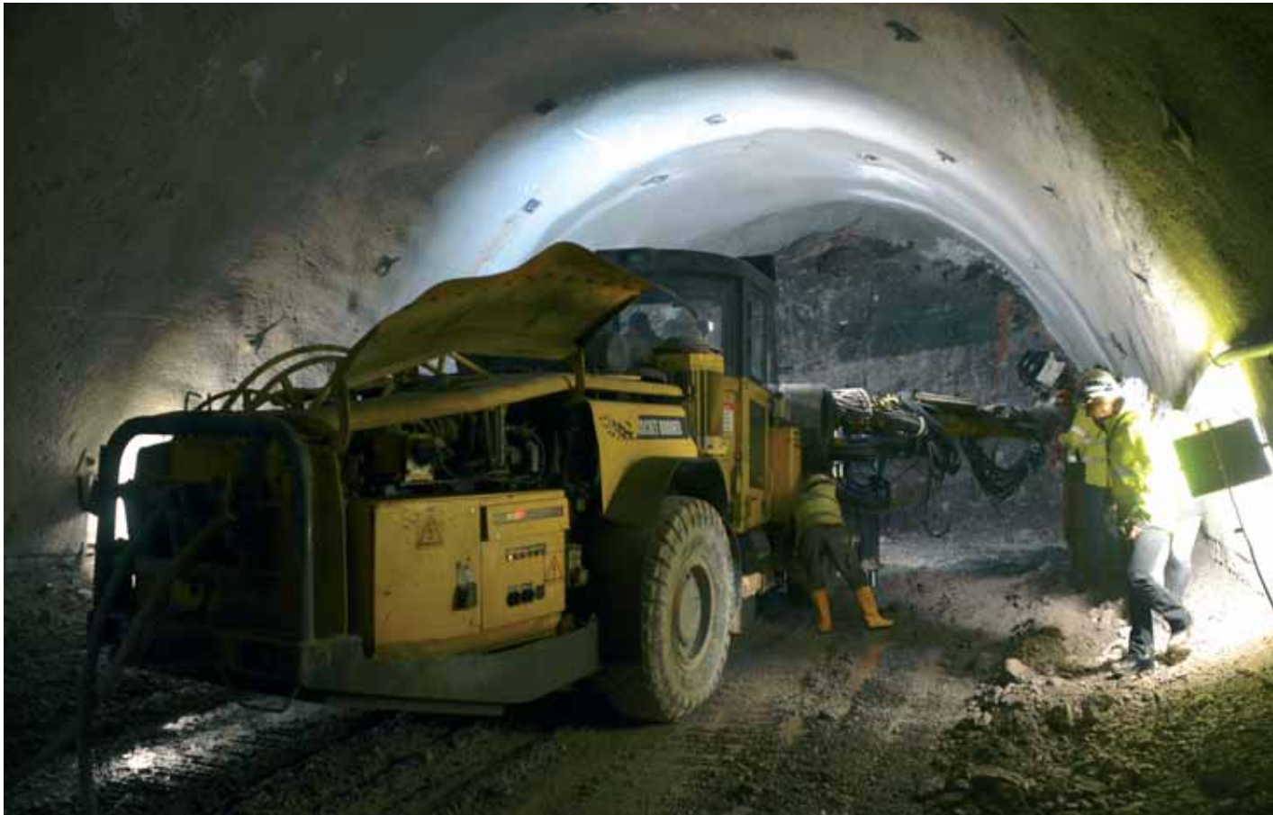
Iskop tunela Mlinarji
