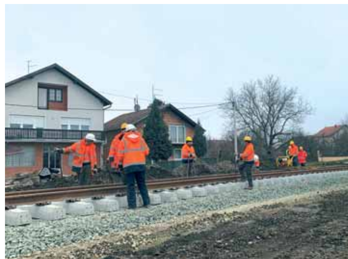
Radovi u Nuštru
