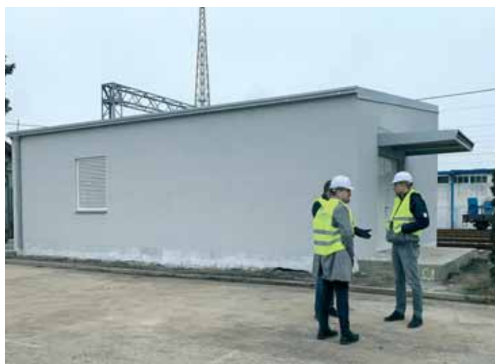
Zgrada za smještaj signalno-sigurnosnih uređaja
