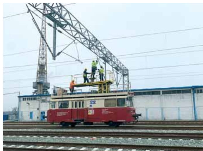
Visoki stupanj završenosti radova na kontaktnoj mreži u kolodvoru Vukovar
