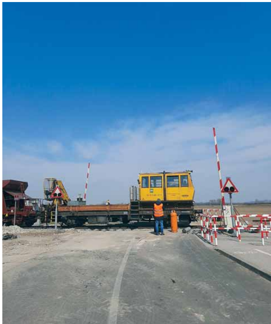
Radovi na željezničko-cestovnom prijelazu
