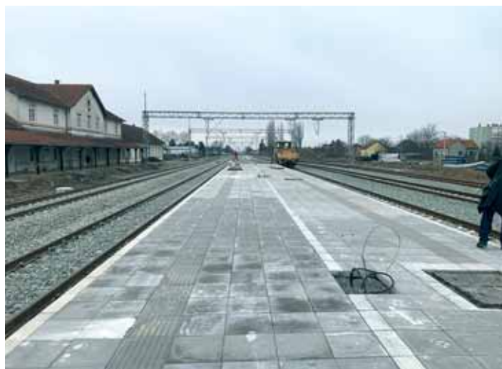
Visoki stupanj završenosti građevinskih radova u kolodvoru Vukovar-Borovo Naselje
