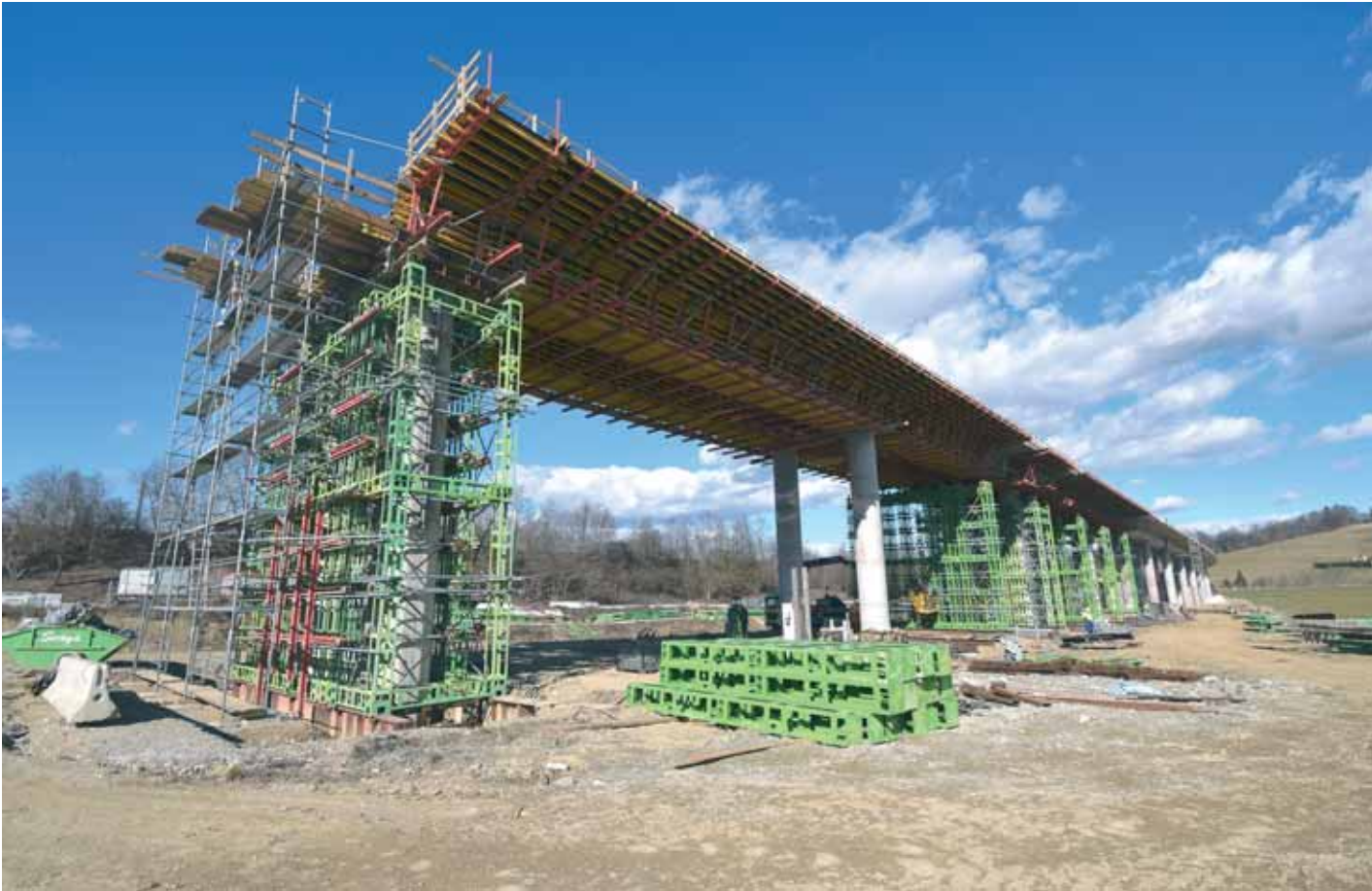
Radovi na južnom kraju vijadukta Pesnica u završnoj fazi
