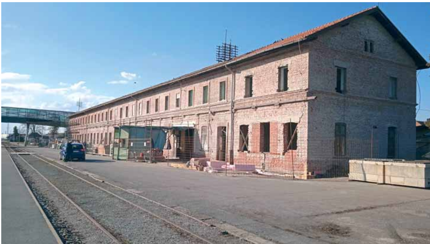
Radovi na rekonstrukciji kolodvorske zgrade u Osijeku
