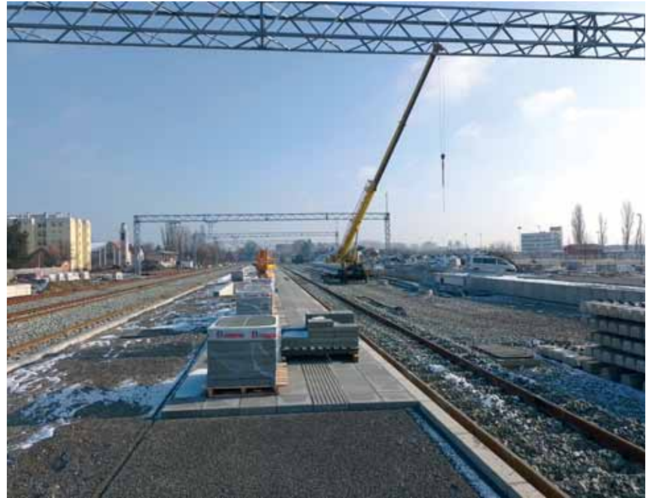
Izgradnja perona u kolodvoru Borovo Naselje
