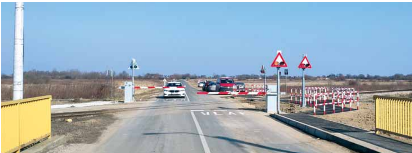
Željezničko-cestovni prijelaz »Vidovec«
