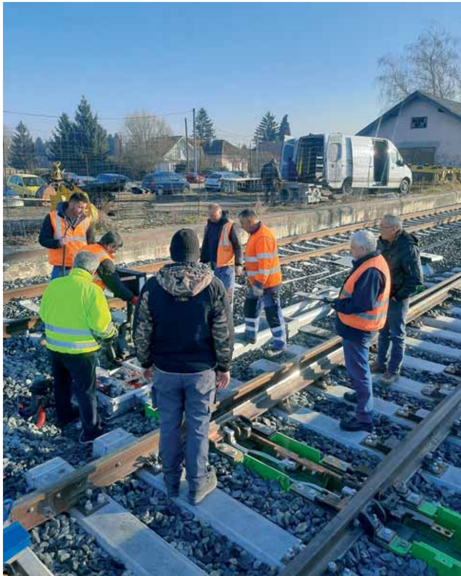
Stručni suradnici i izvođači na funkcionalnom ispitivanju skretnica
