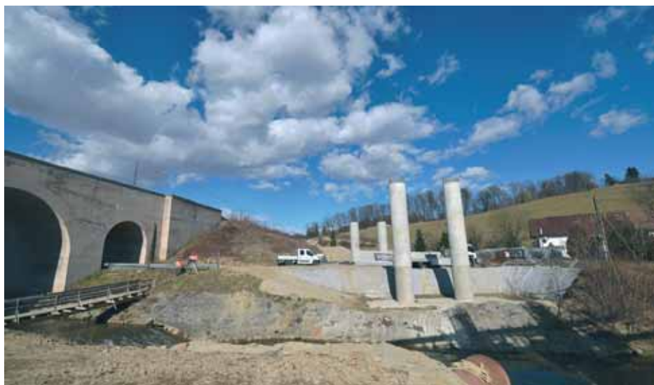
Budući spoj dionice nove pruge od Počehove na staru trasu u blizini Pesnice
