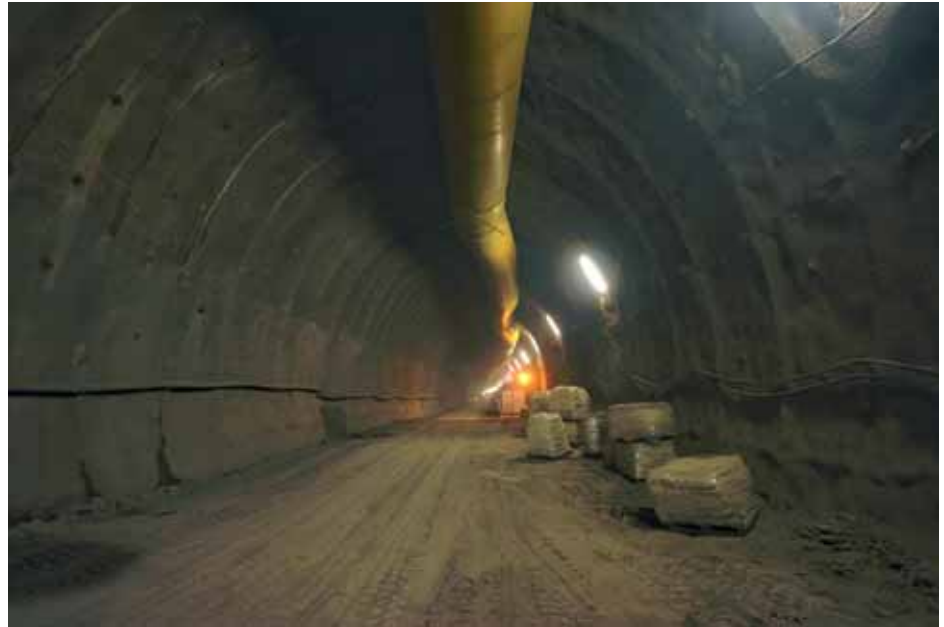
Gradnja dvokolosiječnog tunela Pekel dugog 1530 metara
