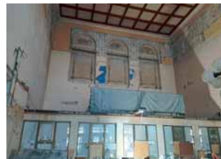
Radovi u vestibulu
