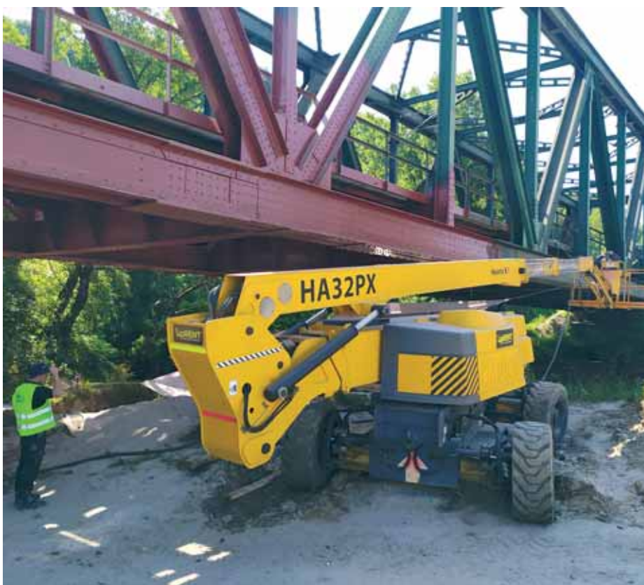
Radovi na mostu Krapina kod Zaprešića
