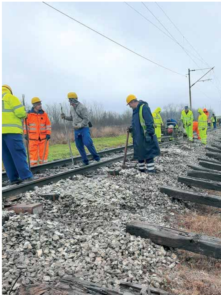
Zamjena starih drvenih pragova
