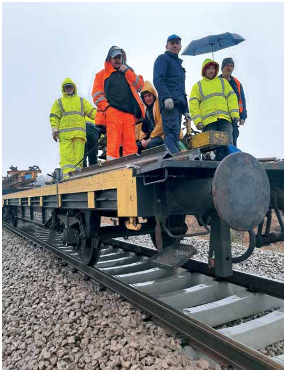
Radni vlak za izmjenu kolosijeka na obnovljenoj dionici pruge Mala Subotica – Donji Kraljevec
