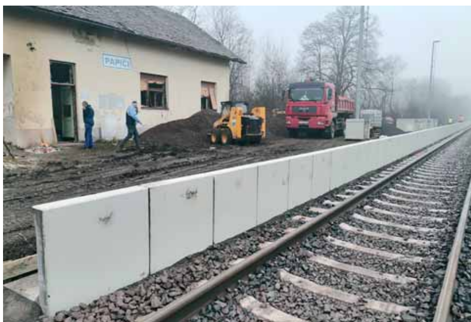
Izgradnja perona u stajalištu Papići
