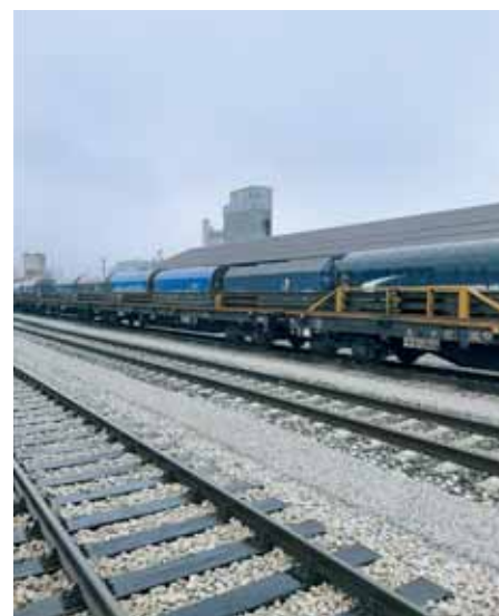
Vlak za prijevoz tračnica na obnovljenim kolosijecima u kolodvoru Čakovec
