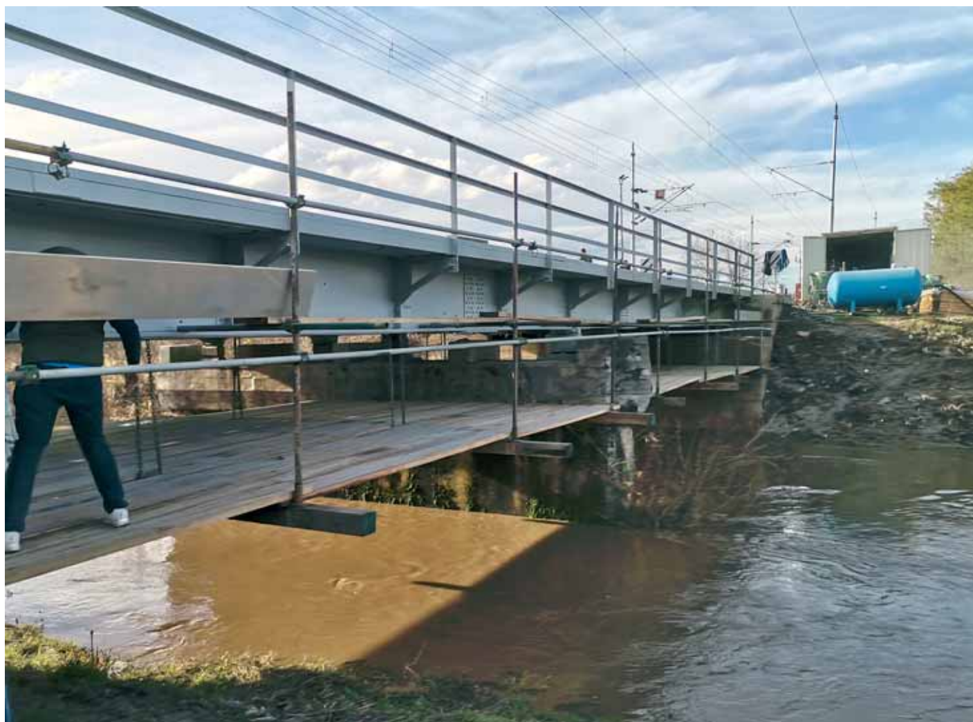
Sanacija i obnova mosta Sunjčića
