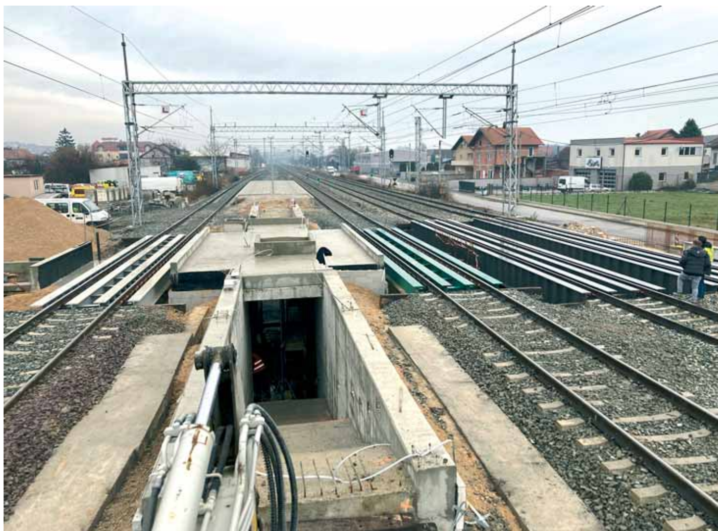
Radovi na pothodniku u stajalištu Sesvetska Sopnica
