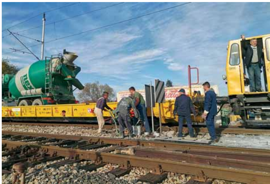
Izlazak mehanizacije za betoniranje na pružnoj dionici
