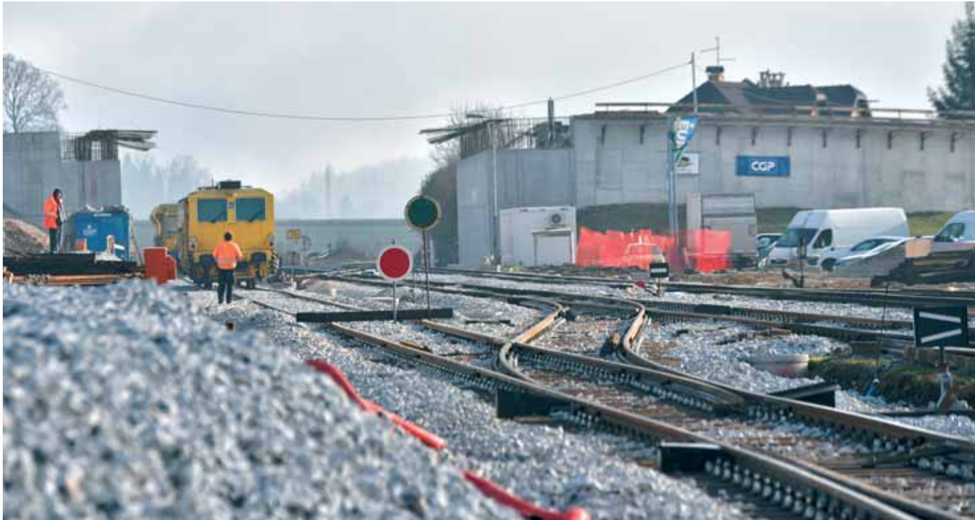
Prikaz dijela gradilišta u kolodvoru Grosuplje
