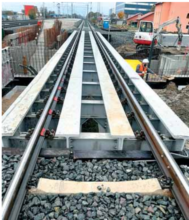
Provizorij iznad pothodnika
