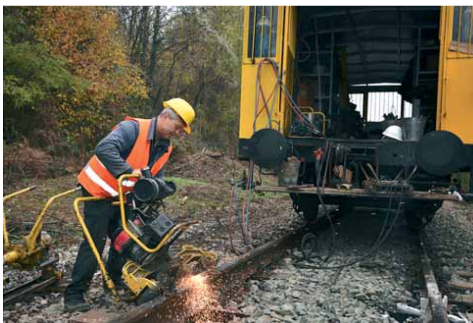
Brušenje tračnica nakon zavara
