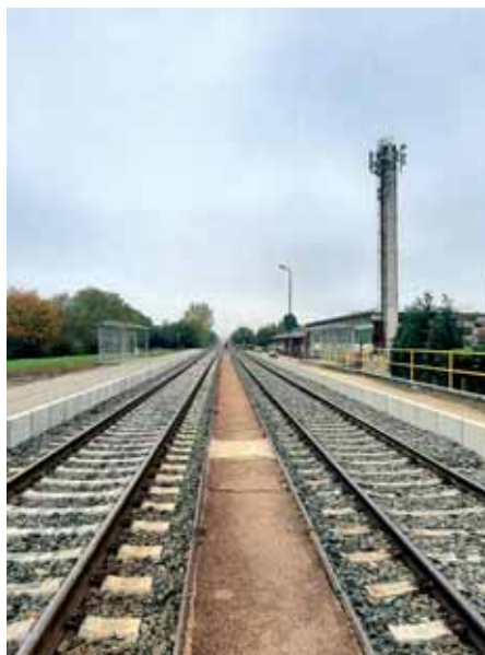
Dovršeni radovi u stajalištu Čakovec-Buzovec
