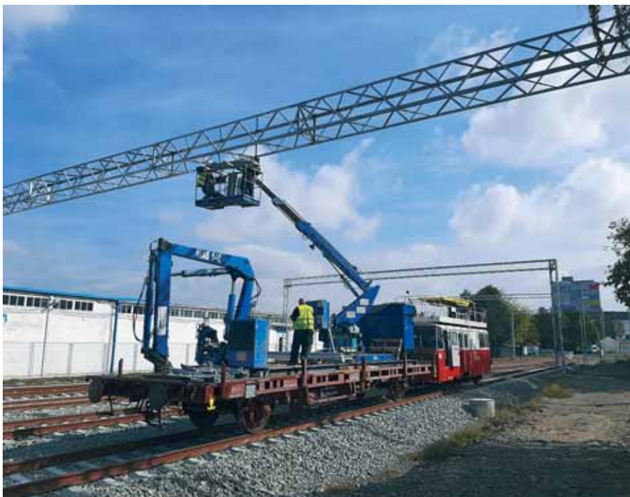
Montaža nosača kontaktne mreže
