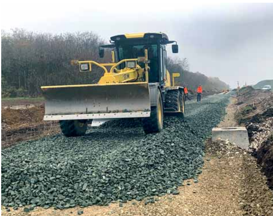
Radovi na lokaciji Pačetin
