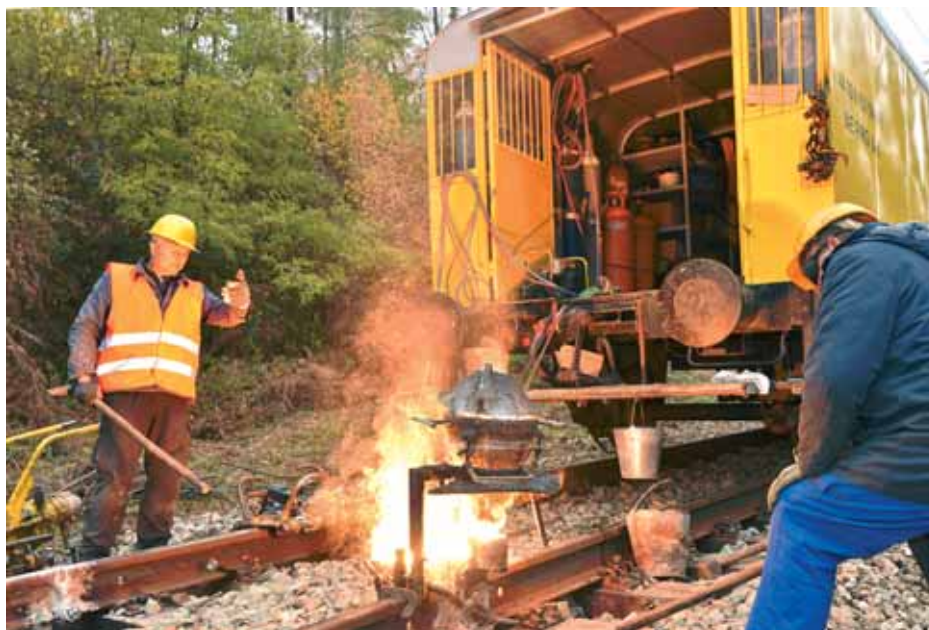
Aluminotermijsko zavarivanje tračnica na dionici pruge Kukača – Gornje Dubrave
