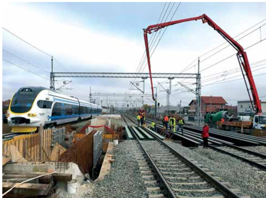
Radova na izgradnji stajališta Sesevska Sopnica
