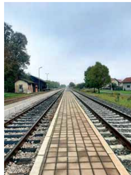
Dovršeni radovi u kolodvoru Mala Subotica
