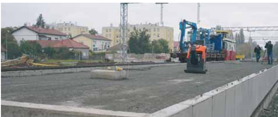
Radovi na izgradnji perona u kolodvoru Vukovar-Borovo Naselje
