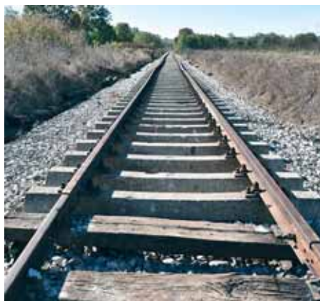
Drveni pragovi zamijenjeni betonskim
