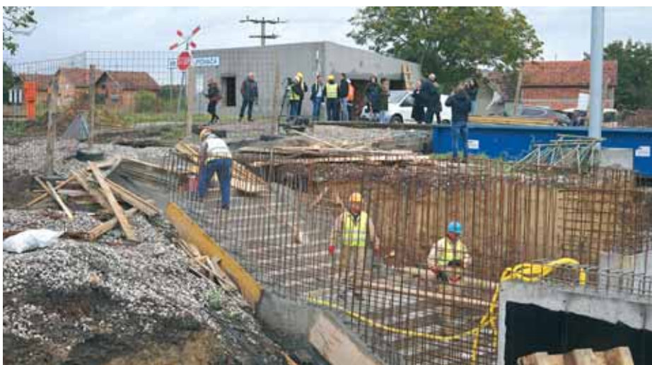
Radovi na pothodniku u stajalištu Bršadin-Lipovača
