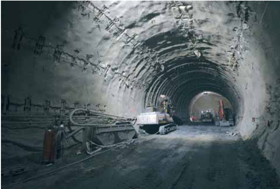
Radovi na probijanju novog baznog tunela
