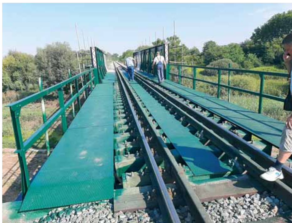
Završeni radovi na antikoroziivnoj zaštiti
