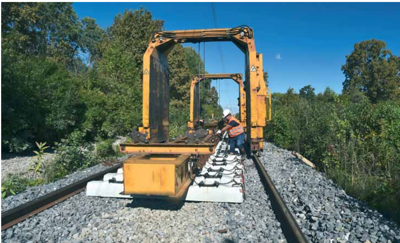
Čitavom dionicom željezničke pruge postavljaju se novi betonski pragovi
