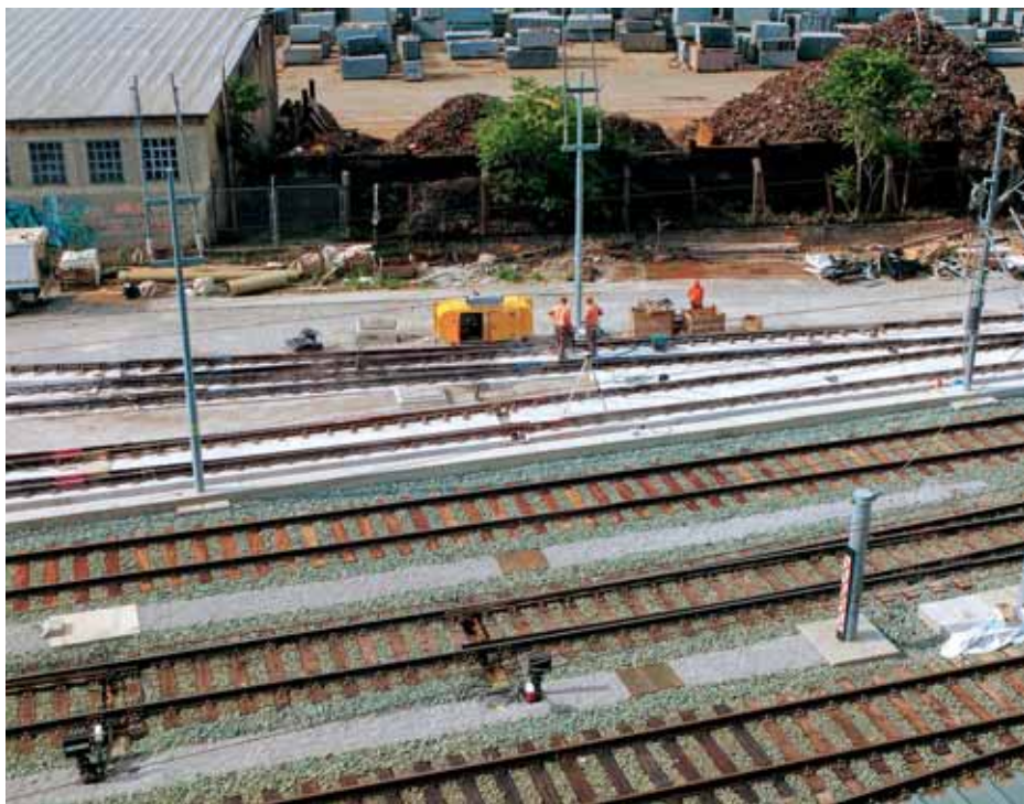
Spoj teretnog dijela kolodvora i novog kontejnerskog terminala na Zagrebačkom pristaništu
