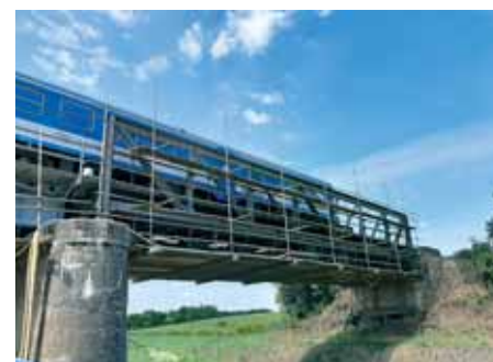
Skele na 1. konstrukciji
