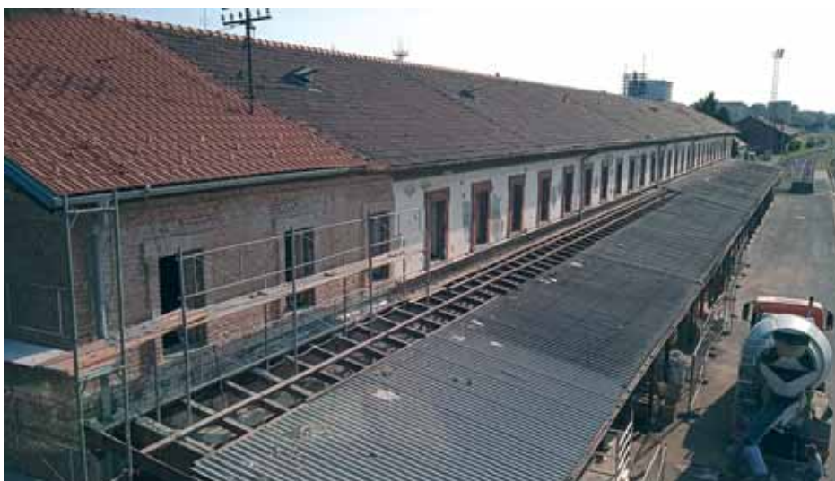
Obnova osječkoga željezničkog kolodvora
