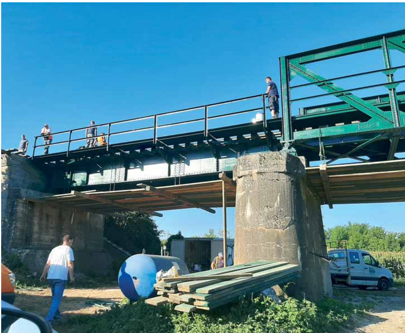
Radovi na 2. konstrukciji
