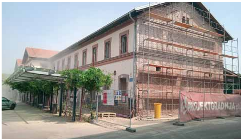
Obnova osječkoga željezničkog kolodvora
