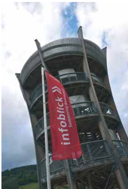
Razgledni stup za posjetitelje na gradilištu baznoga tunela Semmering
