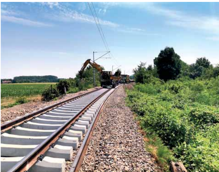
Radovi na otvorenome djelu trase željezničke pruge
