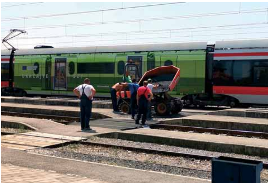
Radovi na ugradnji sintetičkog popođenja u kolodvoru Sunja
