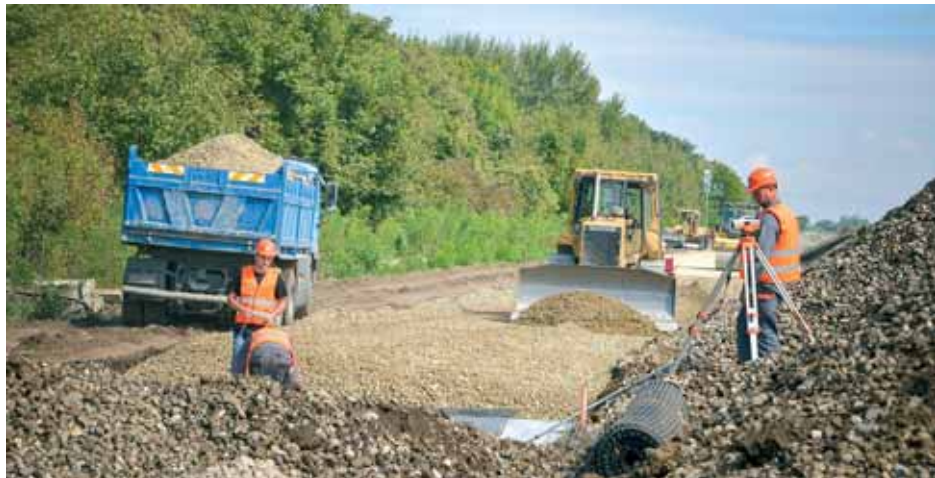
Radovi na otvorenoj pruzi u Pačetinu
