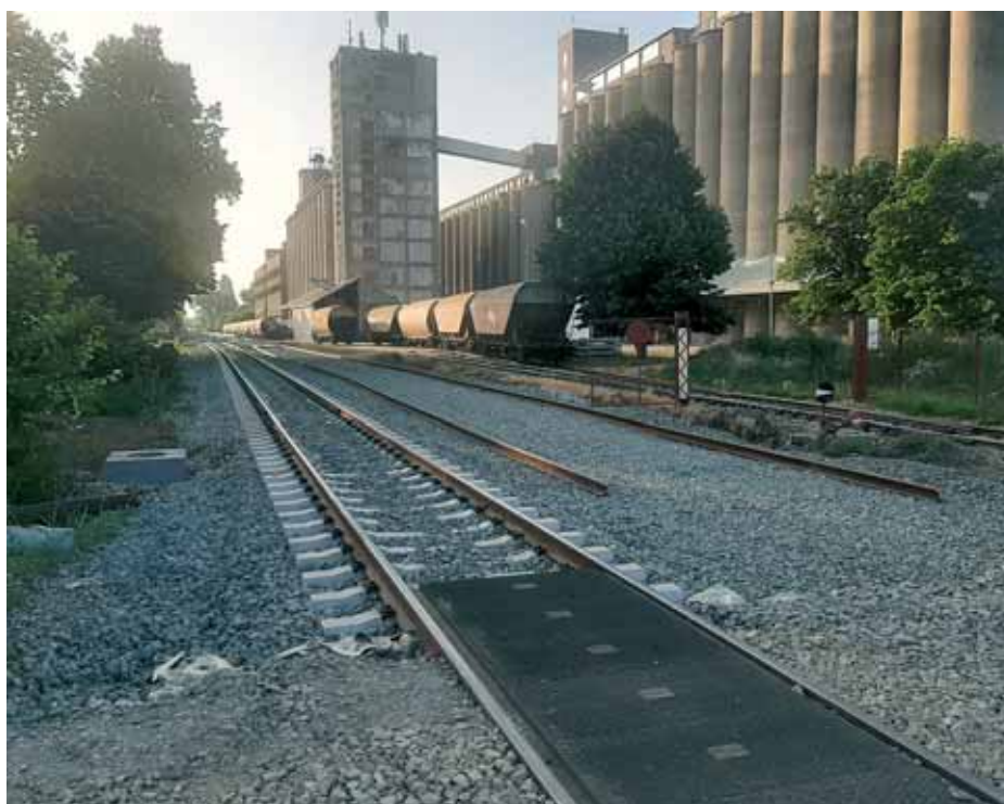
Novi kolosijek u zoni Vupikovih silosa
