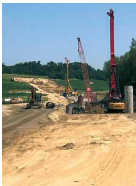
Radovi na vijaduktu Carevdar
