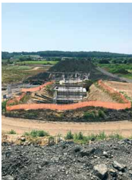
Radovi na nadvožnjaku Križevci
