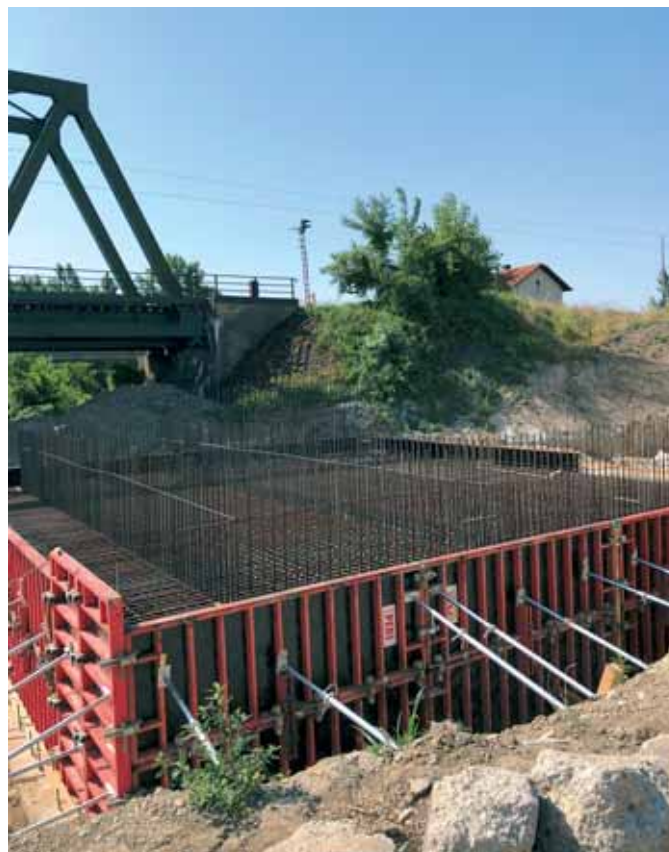
Radovi na donjoj konstrukciji mosta Drava
