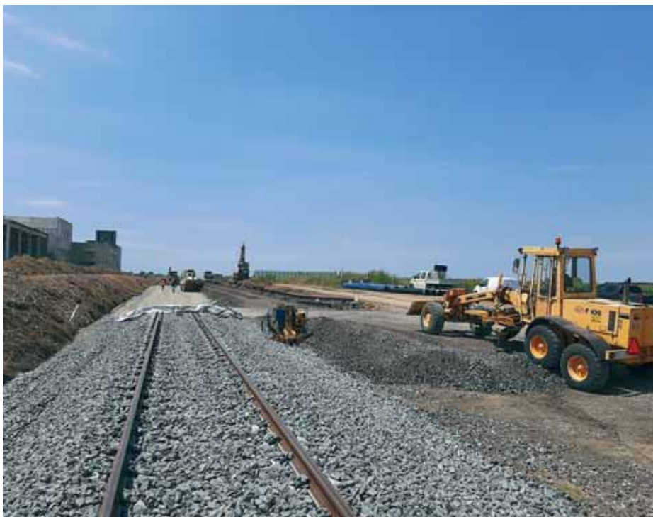
Radovi na otvorenoj pruzi Vinkovci – Vukovar
