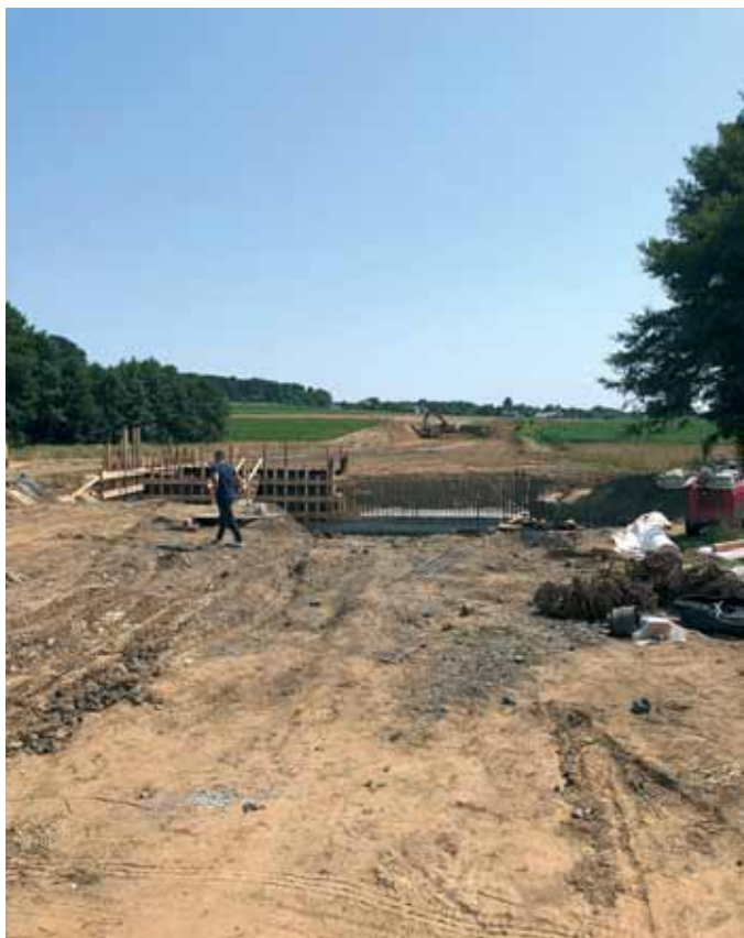
Radovi na donjoj konstrukciji mosta Drava
