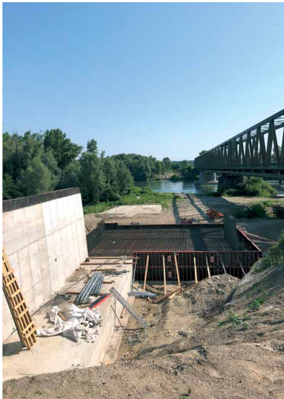
Radovi na donjoj konstrukciji mosta Drava
