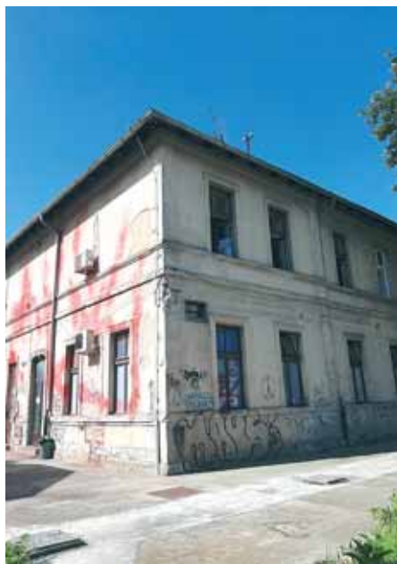
Zgrada vlakopratnje HŽPP-a
