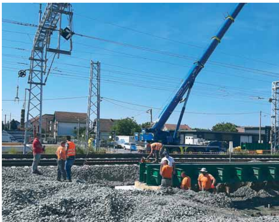
Postavljanje i ugradnja provizorija na pruzi
