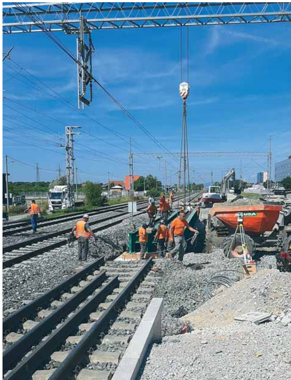
Radovi na devijaciji vodoopskrbnoga cjevovoda
