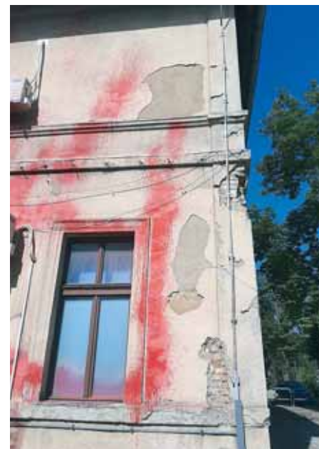
Zgrada vlakopratnje HŽPP-a
