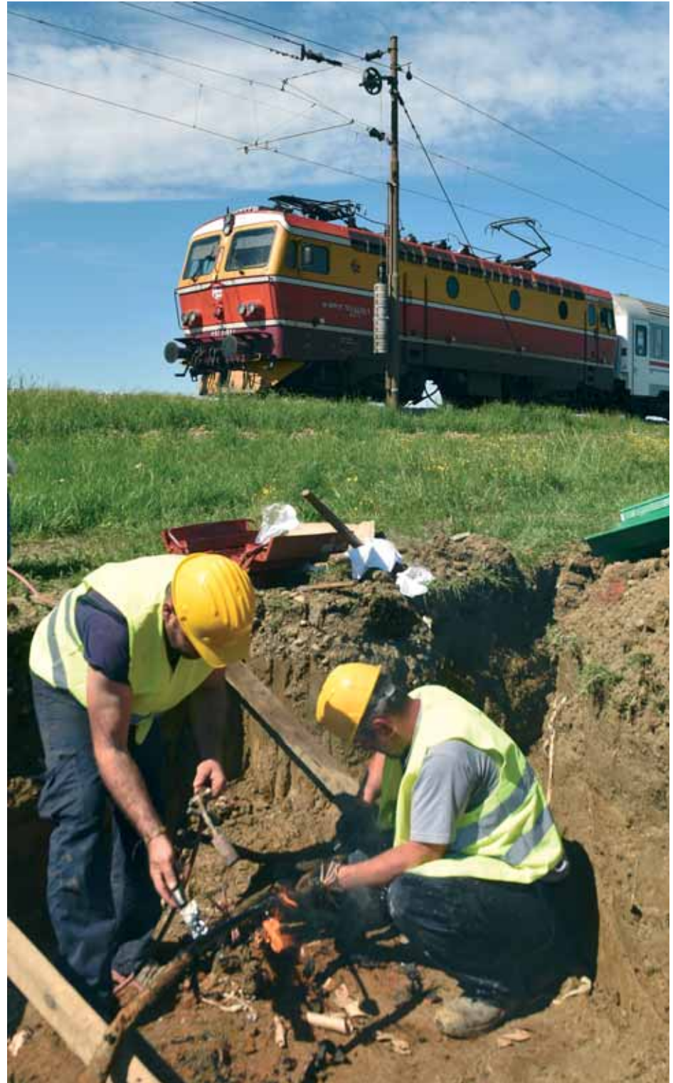
Skidanje izolacijske mase na telekomunikacijskom kabelu
