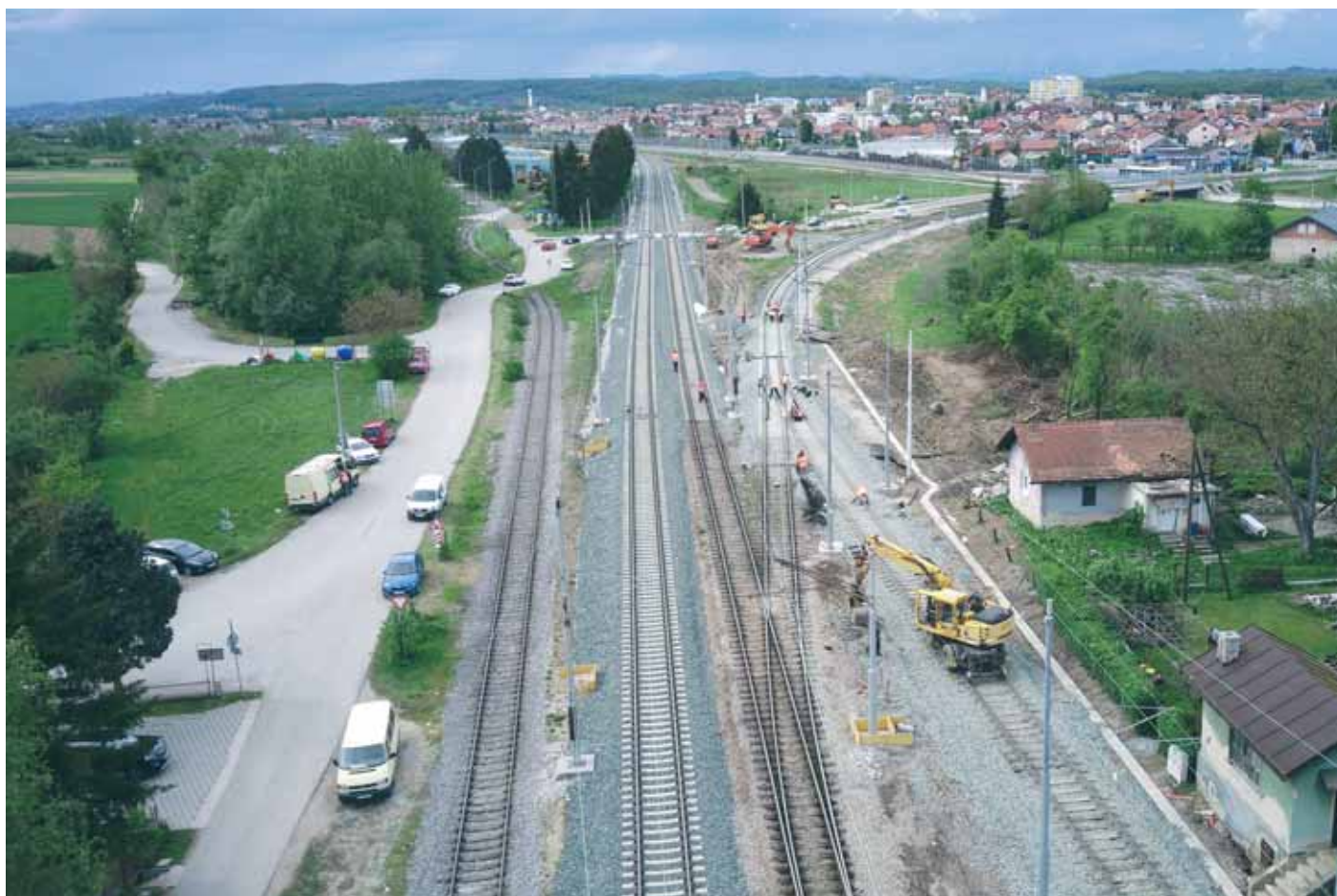
Radovi na izmjeni skretnice br. 27 u kolodvoru Zaprešić
