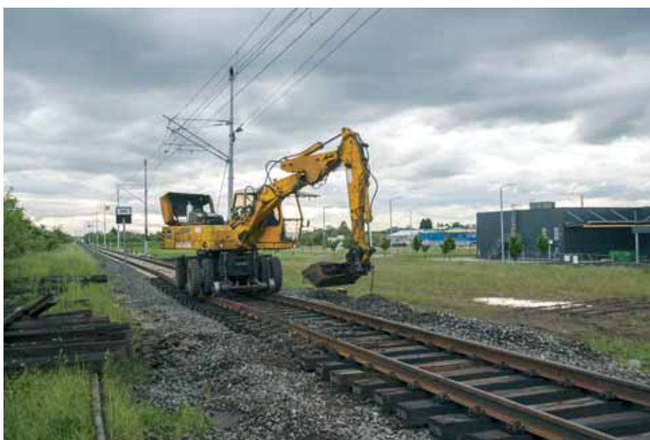
Dvoputni bager na ugradnji tučenca
