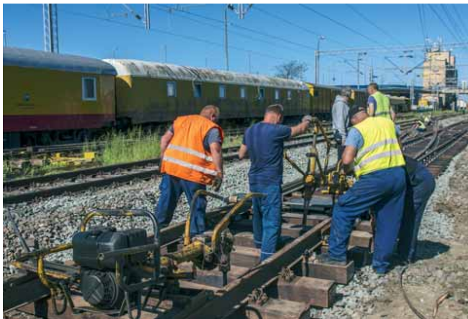
Spajanje kolosijeka i nove skretnice u kolodvoru Sisak
