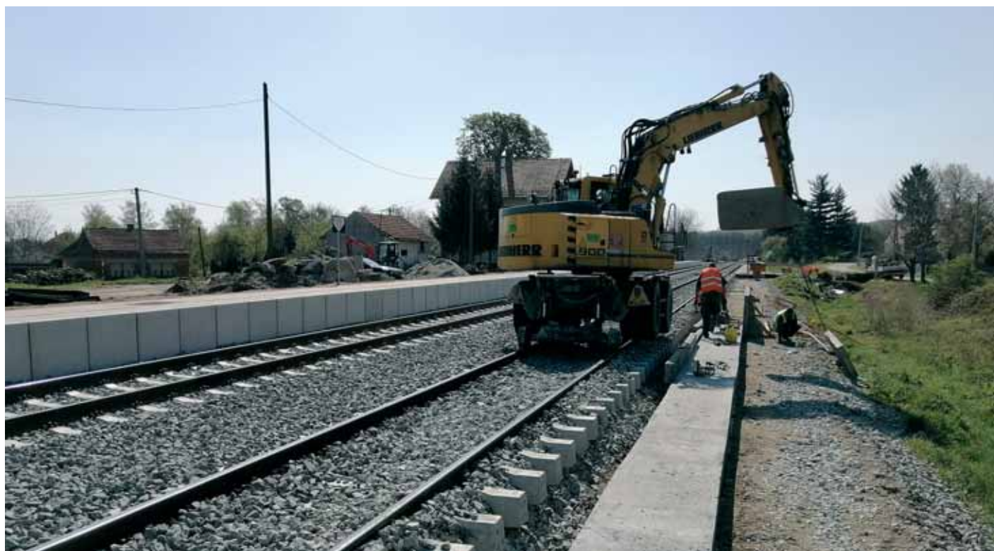
Betoniranje temelja perona u Špišić Bukovici
