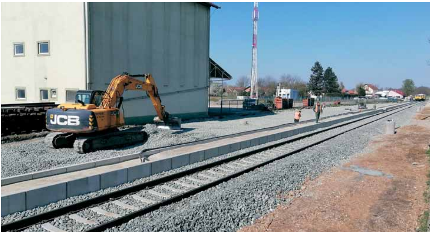
Radovi u kolodvoru Pitomača
