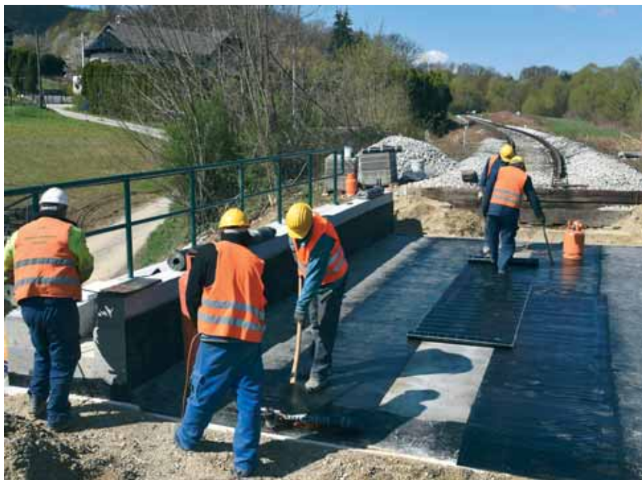
Zaposlenici Pružnih građevina izvode posljednje radove na mostu
