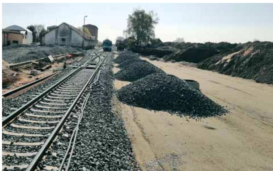
Razastiranje tucanika u kolodvoru Pitomača
