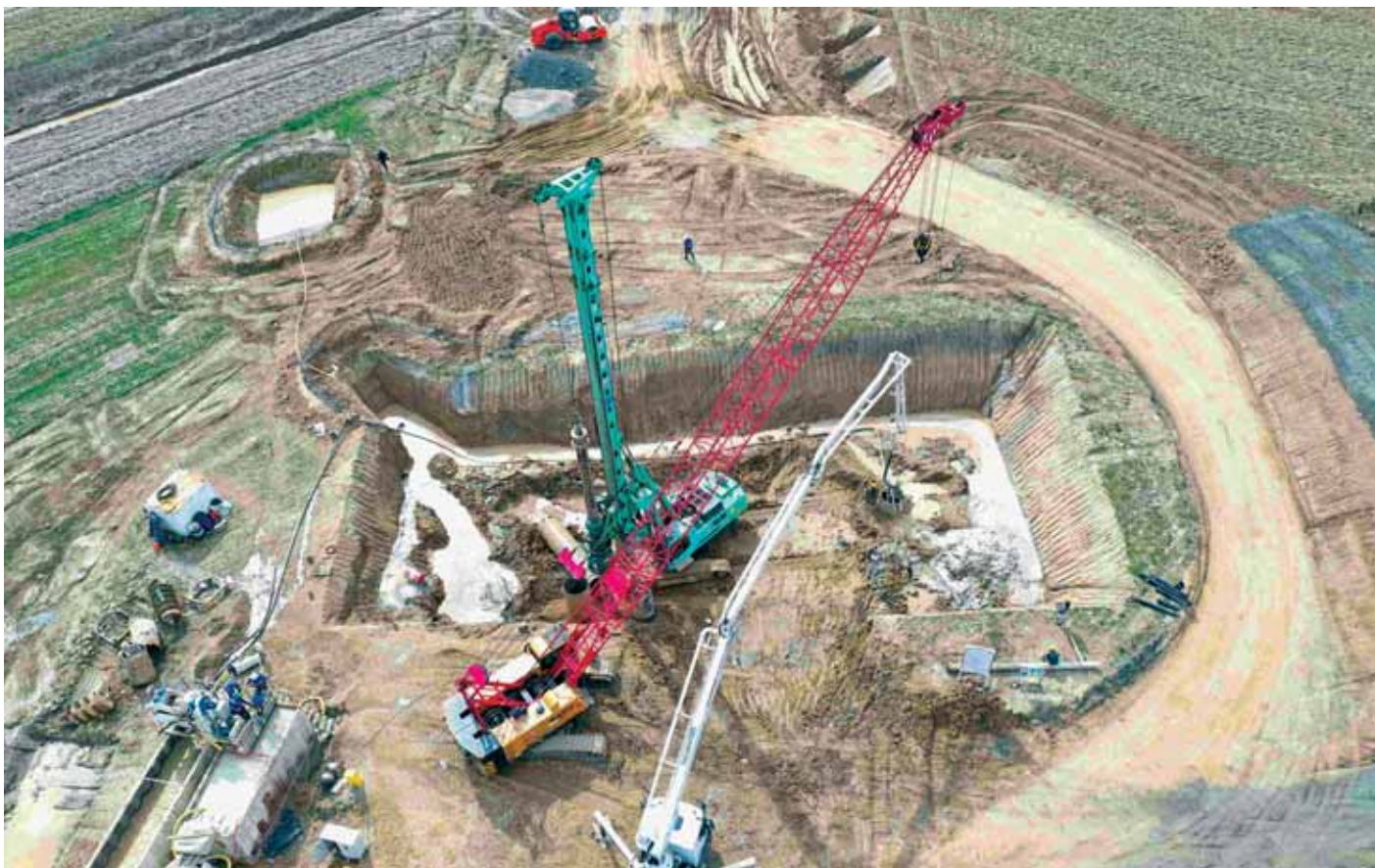
Izvođenje radova na temeljnoj konstrukciji nadvožnjaka Križevci
