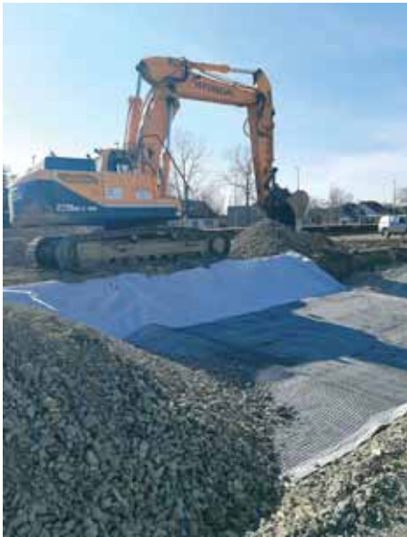
Radovi na izgradnji kolosiječne konstrukcije
