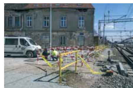
Izrada zaštitne mimoilazne ograde
