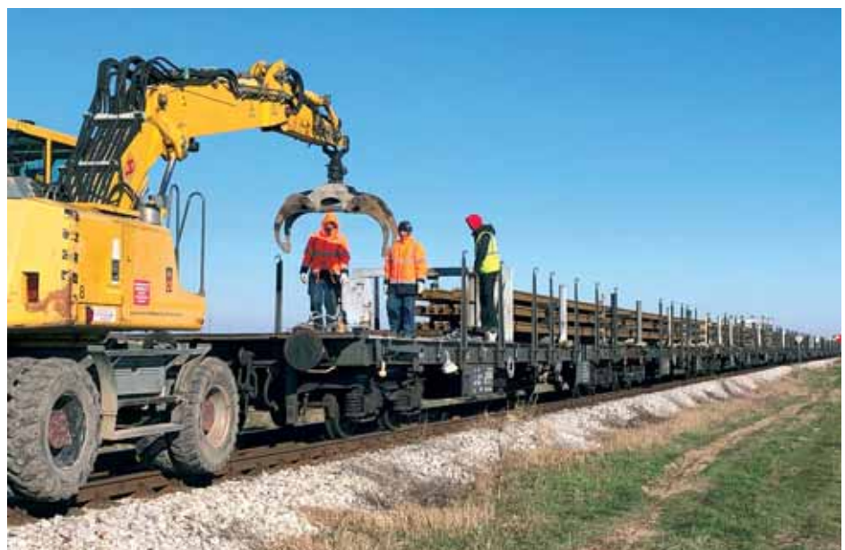
Istovar tračnica
