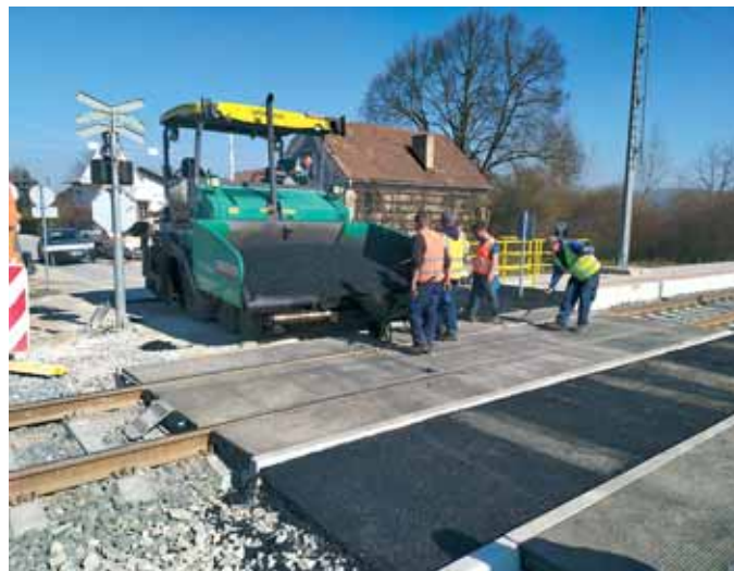
Asfaltiranje ŽCP-a u stajalištu Brdovec
