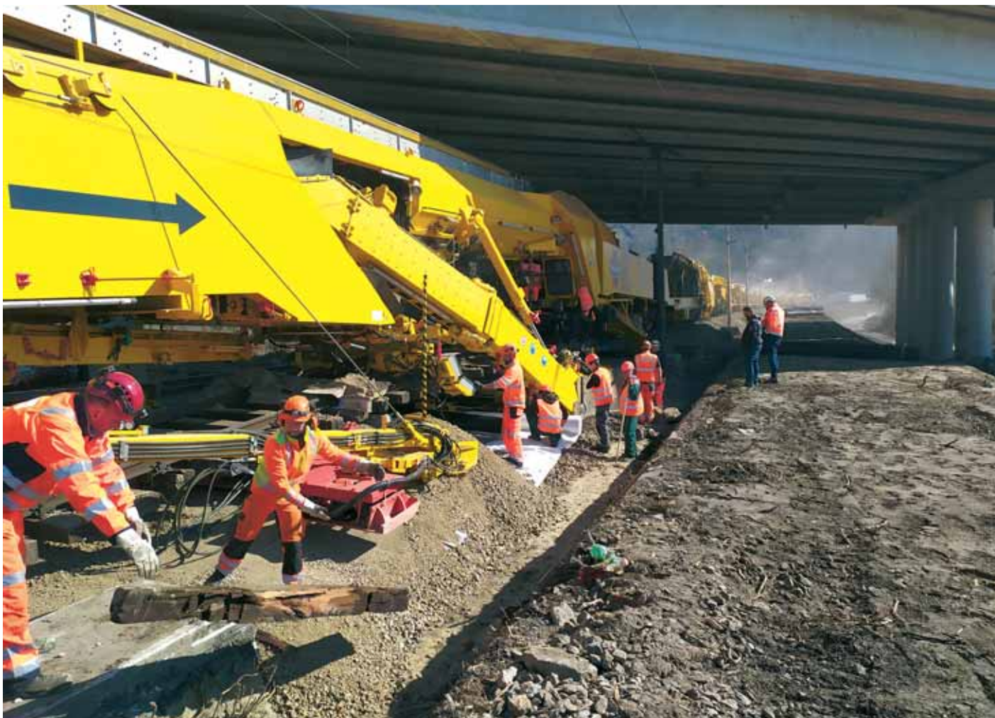
Radovi na ugradnji zaštitnog sloja na dionici Zaprešić - Podsused Tvornica
