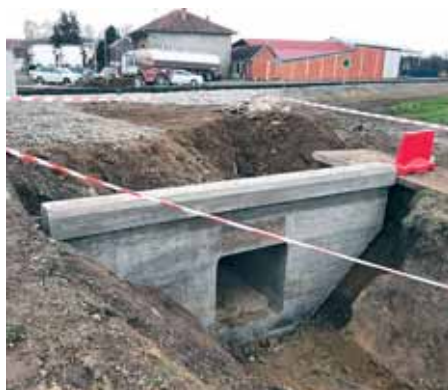
Nuštar I., propust
