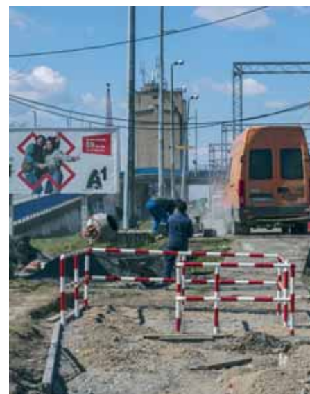
Izrada zaštitne mimoilazne ograde s južne strane
