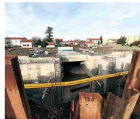
Izgradnja pothodnika u kolodvoru Vukovar-Borovo naselje
