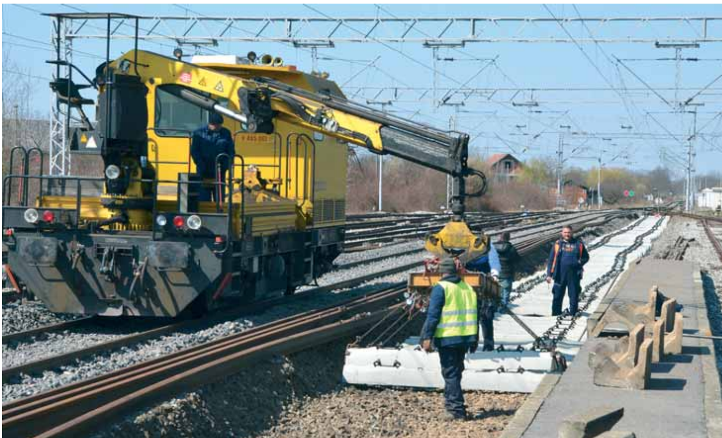
Polaganje betonskih pragova u ležište pružnog pravca
