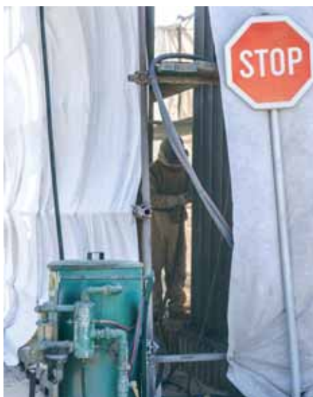
Čišćenje korozije i premazivanje
