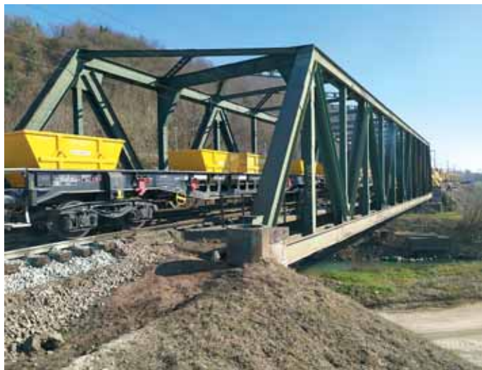
Radovi uz most Krapina
