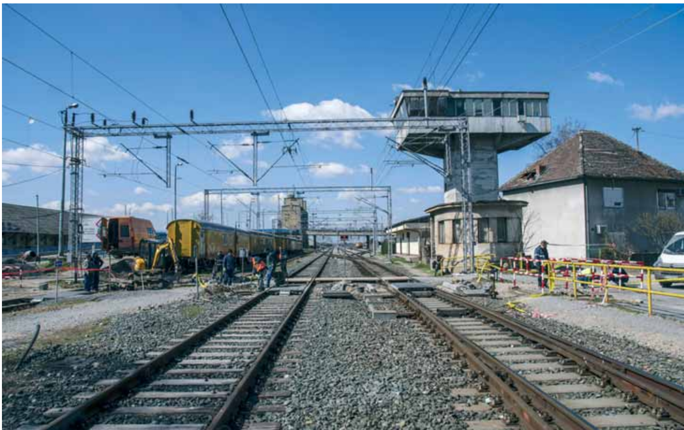
Izrada privremenog pješačkog prijelaza
