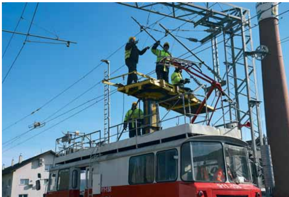
Radovi na kontaktnoj mreži u kolodvoru
