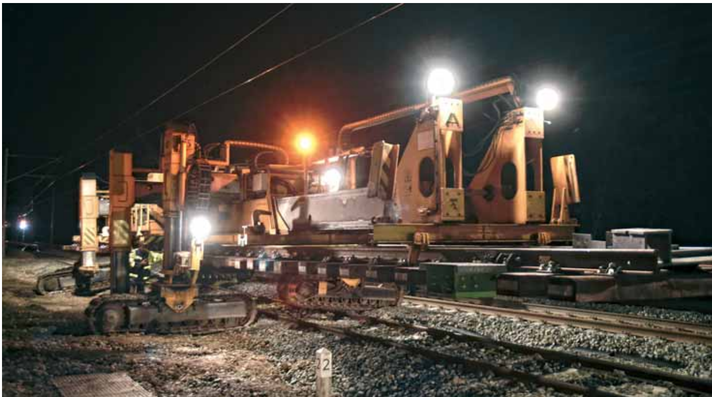
Montaža skretnica uz pomoć DESEC-a u kolodvoru Vrbovsko
