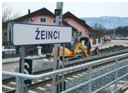
Iskop i polaganje lokalnih kabela – ŽCP Žepci
