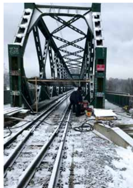
Radovi na sanaciji mosta
