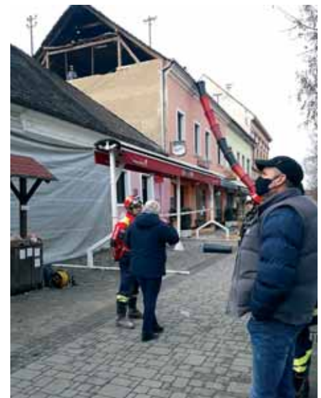
JVP iz Šibenika na sanaciji krovova u Glini
